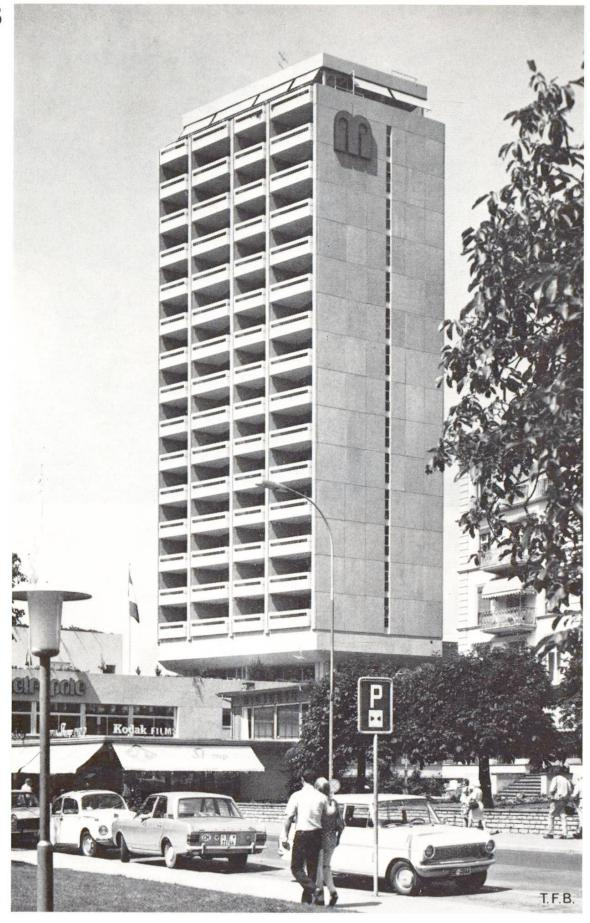
7 Vorfabrizierte Fassadenteile an einem Hochhaus. Die Balkonbrüstungen aus glatter dichter Schalung sind gleichmässig hell. Die Platten der Seitenfläche haben sandgestrahlte Oberflächen. Je nach Behandlungstiefe erscheinen sie im Grauton etwas verschieden, was eine angenehme belebende Wirkung erzeugt.
