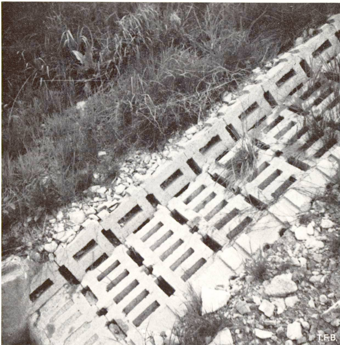
Abb. 7 Beispiel einer kleinen Hochwasserentlastung an einem Strassendamm.
