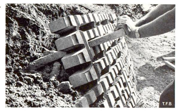
Abb. 4 Befestigung einer Böschung. In eine grössere Öffnung des Gittersteins kann eine brettförmige Verankerung aus Beton eingeschoben werden.
