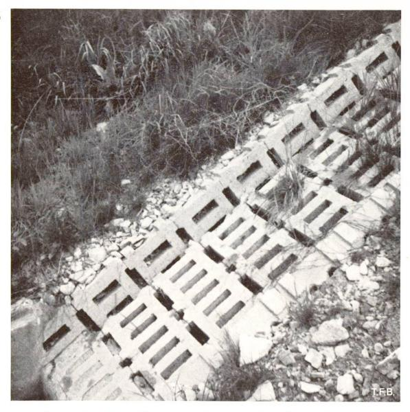
Abb. 7 Beispiel einer kleinen Hochwasserentlastung an einem Strassendamm.
