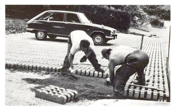
Abb. 2 Verlegen von Rasensteinen für eine Parkfläche. Die Elemente werden ähnlich wie eine Pflästerung in Sandbett verlegt, und die Öffnungen werden mit Humus gefüllt. Das Flächenverhältnis zwischen Beton und Erde beträgt ca. 1:2.
