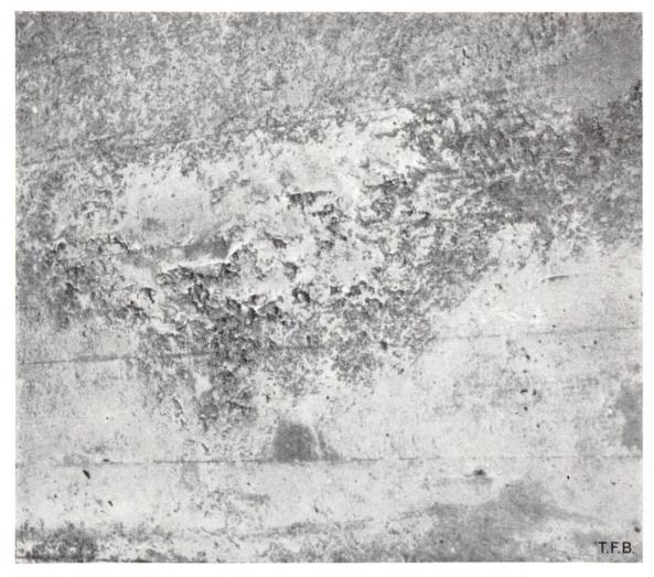
Abb. 3 Grosses Kiesnest, teilweise mit zugeflossenem Mörtel ausgefüllt.
