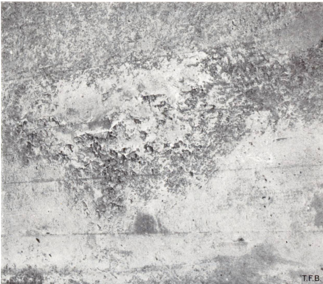
Abb. 3 Grosses Kiesnest, teilweise mit zugeflossenem Mörtel ausgefüllt.
