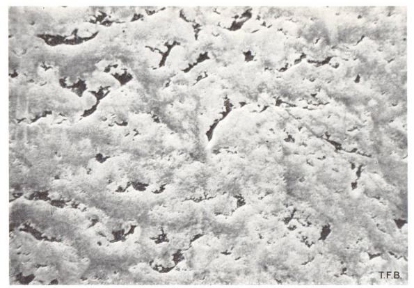
Abb. 4 Kiesnest, das während der Vibration teilweise ausgefüllt worden ist. Man erkennt die typisch schlierenförmigen Hell-Dunkel-Verfärbungen des Mörtels infolge Wasser-Zementmischung während des Fliessvorganges (hell: mehr Wasser, dunkel: mehr Zement).
