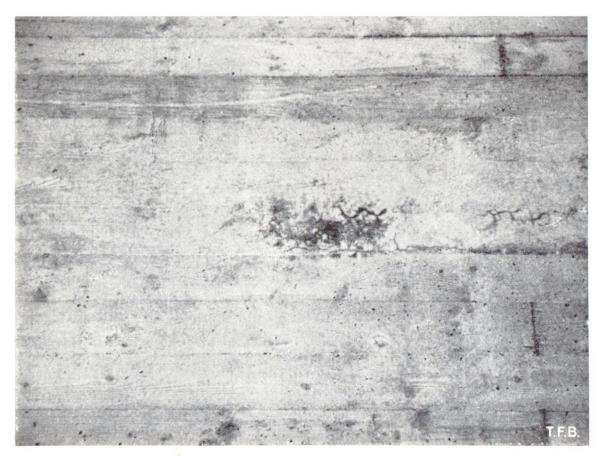
Abb. 5 Kleines, vollständig geschlossenes Kiesnest. Es sind nur noch die in diesem Falle besonders starken Verfärbungen zu sehen.
