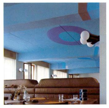
Grundton ist in der Halle rot, in den Mehrzwecksälen ocker, im Essraum blau und im gedeckten Freiplatz hellblau. Die Bemalung wurde mit Acrylfarbe auf die Prelamplatten (vorfabrizierte Betondeckenplatten) nach einem vorhergehenden Strukturanstrich aufgebracht. Die Grundtöne wurden von einer Malerfirma erstellt, die Bilder von Carlos Duss zusammen mit einem Gehilfen
