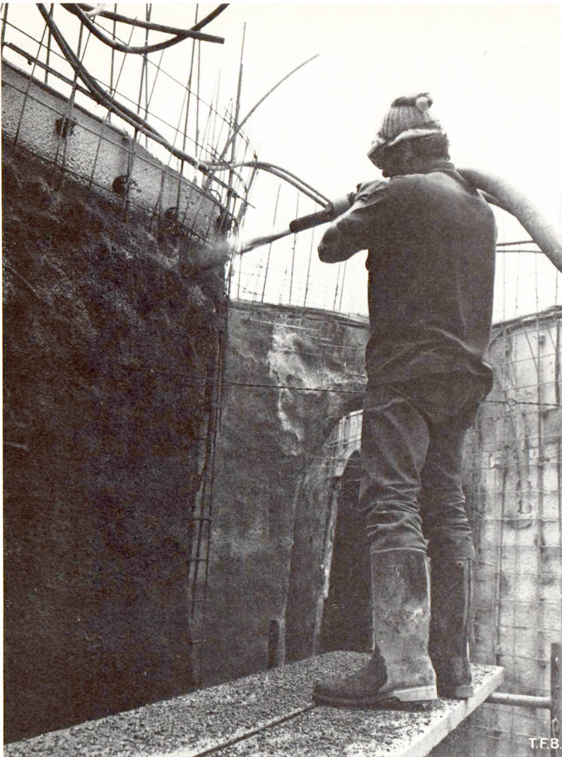
Abb. 5 Auftrag der ersten Schicht auf Isolationsfläche.
