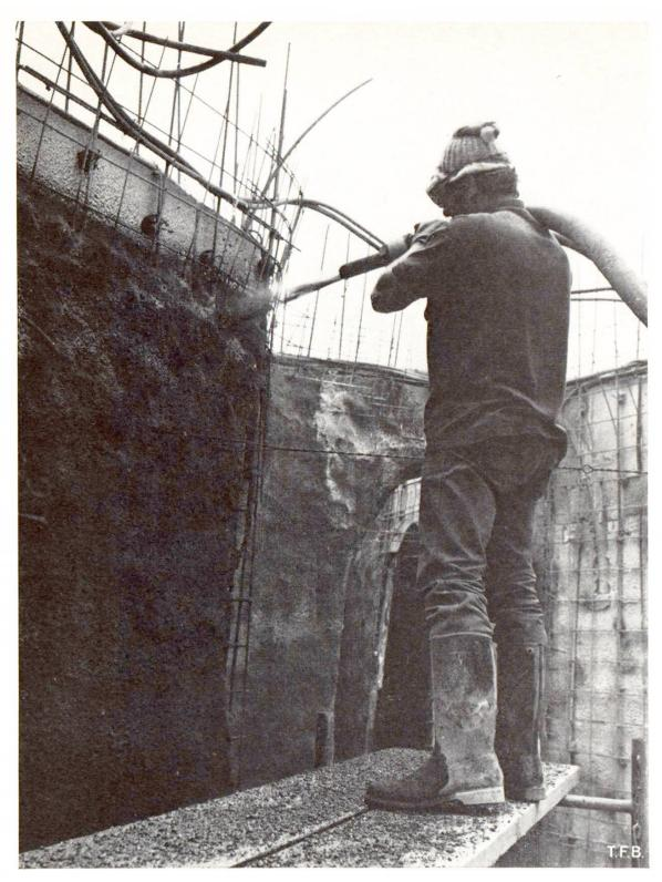
Abb. 5 Auftrag der ersten Schicht auf Isolationsfläche.
