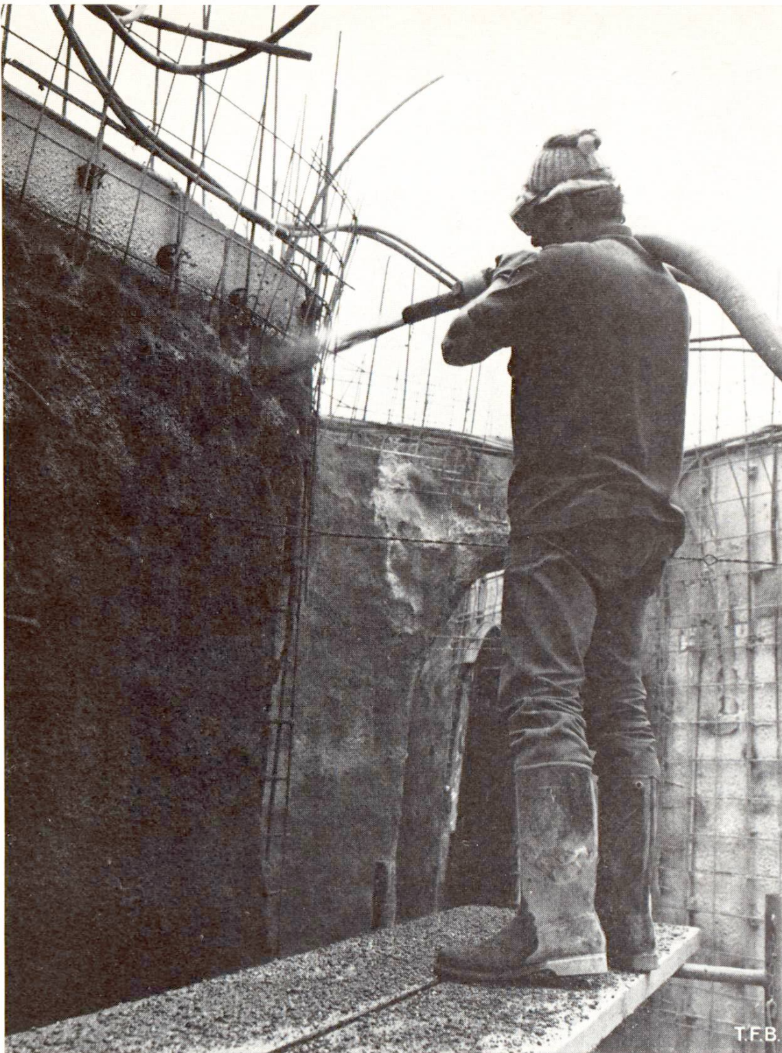
Abb. 5 Auftrag der ersten Schicht auf Isolationsfläche.
