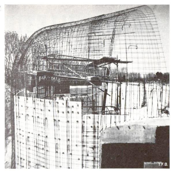
Abb. 1 Verlegung der Armierungen und der Wärmeisolation.
