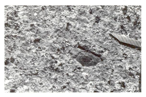
Abb. 8 Zustand der Betonoberfläche bei vollständiger Entfernung der Gummirückstände unter gleichzeitiger leichter Aufrauhung. Vom Material der Betonoberfläche wird nichts entfernt, das die Konstruktion der Decke oder die Form der Struktur wesentlich beeinträchtigt.
