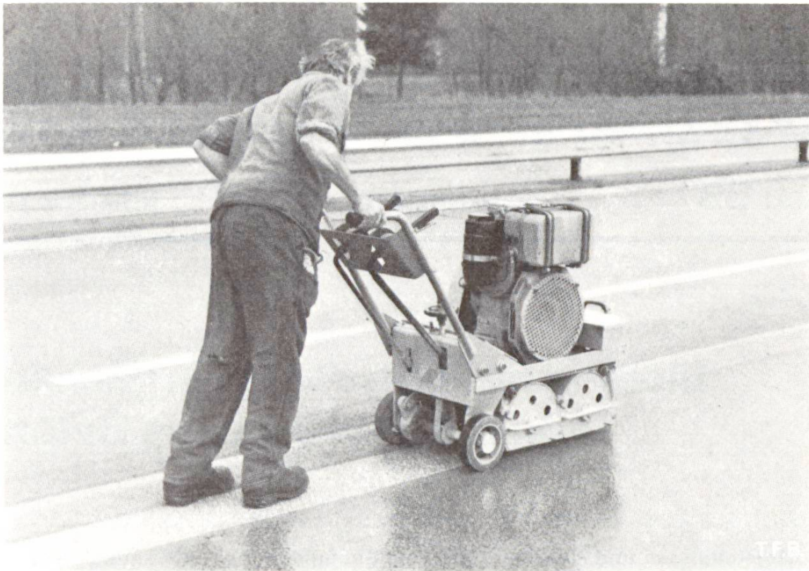
Abb.1 Oberflächenbehandlung des Betonbelages einer Autobahn. Die Maschine erwirkt eine gleichmässige und regulierbare Aufrauung der Oberfläche mittels einer gesteuerten, aber nicht aufgezwungenen Schlagwirkung. Zusätzlich ist eine automatische Korrektur der Ebenheit der zu behandelnden Oberfläche durch eine Vorrichtung für ein selbständiges Ausgleichen mit stufenweisem Fortschritt eingebaut, nebst einer steuerbaren Geschwindigkeit des automatischen Vortriebes (Fabrikat: Maschinenfabrik von Arx, Sissach, Schweiz).
