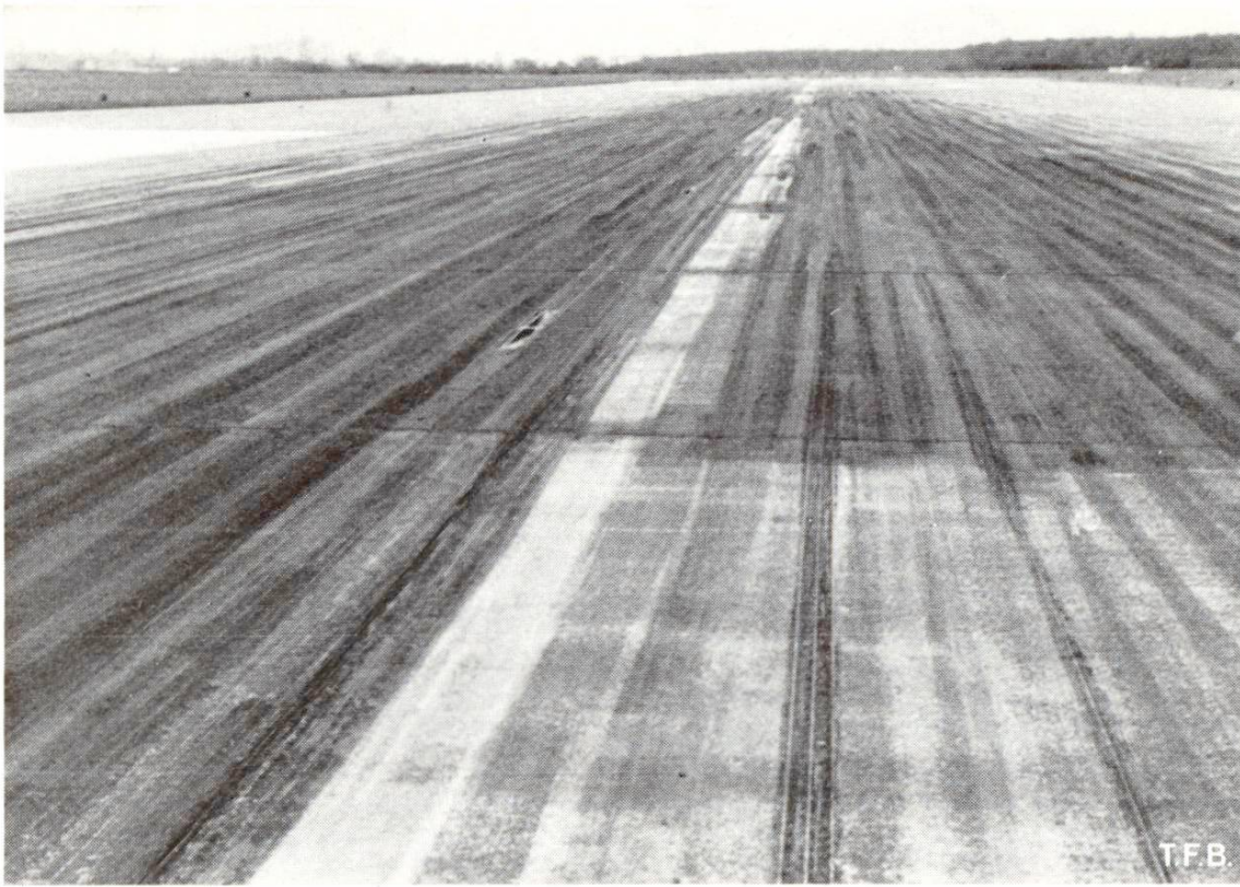
Abb. 3 Ein Teil der mit Gummiregenerat überzogenen Landepiste. Die Partie im Vordergrund rechts wurde der Behandlung unterzogen, zeigt aber bereits neue Radspuren eines inzwischen gelandeten Flugzeuges.
