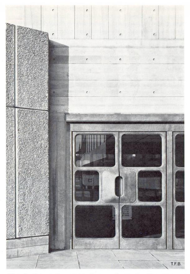
Abb. 8 Einzelheiten der Fassade bei den Eingängen: Aluminiumtüren, körnige Platten und formenreicher, regelmässiger Sichtbeton. Man erkennt hier die Ausbildung der Bindelöcher: Sie sind kreisrund mit dichtem, ebenem Mörtelverschluss, 10 mm zurückversetzt.
