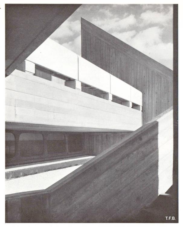
Abb. 3 Sichtbeton aus sorgfältig erstellten Schalungen mit gehobelten und rauhen Brettern. Formgebung der abfallenden Mauerkrone unmittelbar nach dem Verdichten des Betons.
