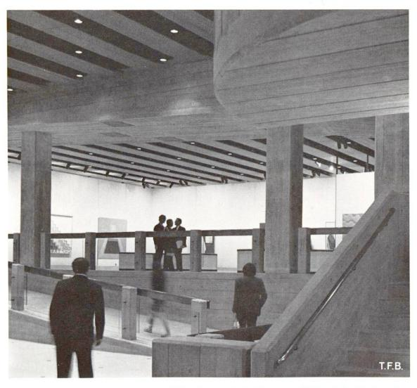
Abb. 7 Auch in den Innenräumen bleibt die natürliche Betonoberfläche frei sichtbar. Hier kommt die hochstehende handwerkliche Arbeit des Betonierens besonders zur Geltung.
