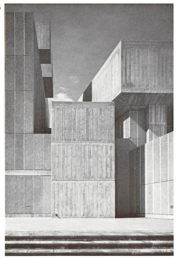
Abb. 5 Diese Aufnahme zeigt die beiden Hauptmotive der Betonfassaden, die «Holzkisten-Schaltafel» und die hochgestellte Platte mit freigelegtem Zuschlagskorn.
