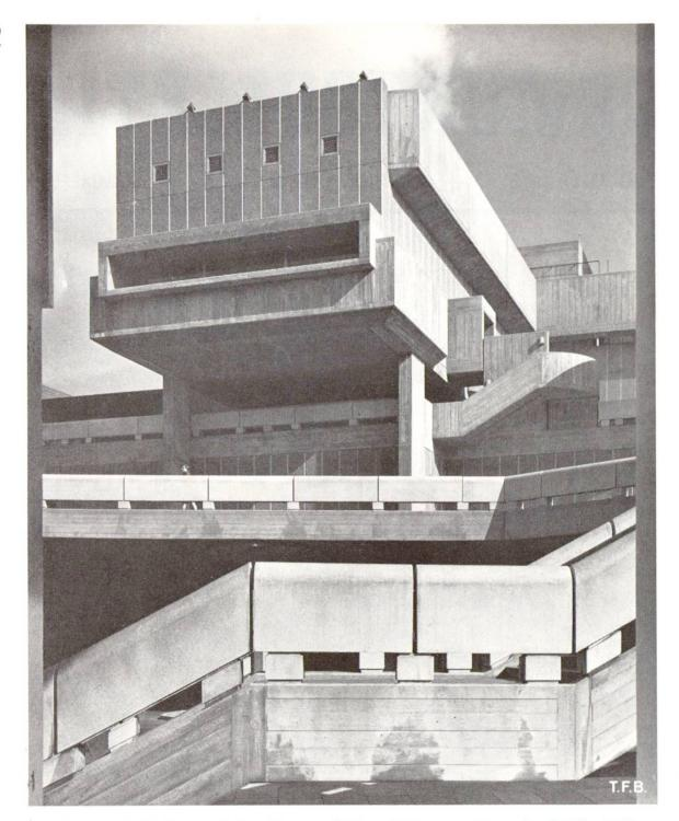
Abb. 1 Ansicht der Hayward-Artgallery von Süden mit dem vorspringenden Teil des 5. Ausstellungsraumes. Auffallend ist die Kombination von Ortsbeton und vorfabrizierten Betonelementen an den Fassaden und den ausgedehnten Terrassen.
