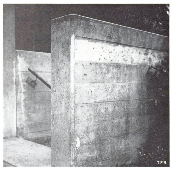
Abb. 3 Alterungserscheinungen an einer kleinen Mauer aus Ortsbeton.
