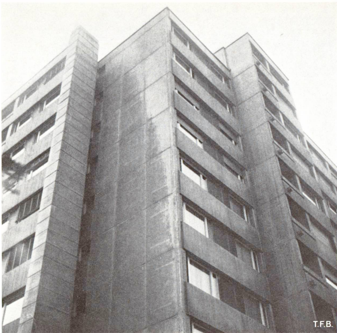
Abb. 2 Fassadenteil mit sichtbarem Einfluss von Schlagregen.
