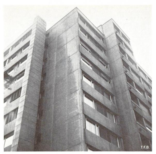
Abb. 2 Fassadenteil mit sichtbarem Einfluss von Schlagregen.
