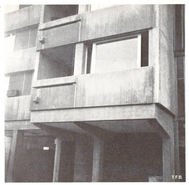
Abb. 1 Brüstungsplatten mit verschiedener charakteristischer Verteilung des Grautones.
