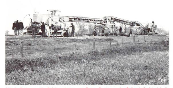
Abb. 1 Einbauzug für Geleiseunterbau aus Beton. Rechts an der Spitze befindet sich die Betonaufgabe mit anhebbarem Vorratssilo. Es folgen zwei fahrbare «Kranböcke» mit den Armierungsnetzen für die untere und obere Bewehrungslage und schliesslich der Gleitschalfertiger und die Maschine, welche die Dübellöcher im frischen Beton erstellt (ganz links). Über die Kranböcke führt das Transportband für den Frischbeton.
