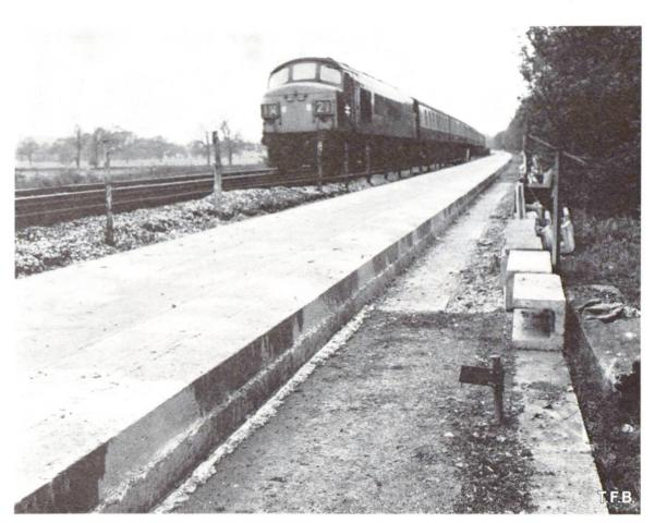
Abb. 4 Betonband für Geleisebau im Rohbau fertiggestellt. Es handelt sich um die Versuchsstrecke für den ordentlichen schweren und z.T. extrem schnellen Zugsverkehr.
