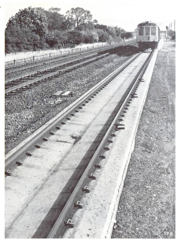
Abb. 2 Versuchsstrecke für U-Bahnen. Die Schienen liegen auf Platten aus etwas nachgiebigen Materialien. Dies bedingt auch eine federnde Befestigung.
