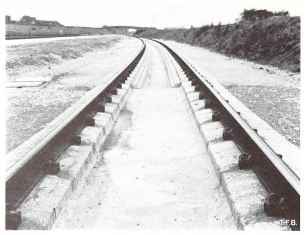
Abb. 3 Versuchsstrecke für den Geleisebau in einem zukünftigen Tunnel unter dem Aermelkanal.
