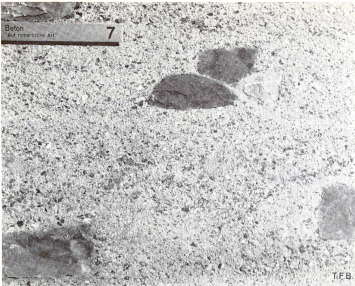
Abb. 7 und 8 Stützmauer mit Anzug wie Abb. 1 und 2. Aufnahmen 1962 bzw. 1972. Rohgestockter Beton mit eingeschlossenen grösseren Natursteinen. Der farbliche Gesamtaspekt ist bei diesem Mauerstück unruhiger geworden. Die gebrochenen Flächen der Natursteine haben ihre Farbe teilweise stark geändert. Die entstandenen wolkenförmigen Grautönkontraste sind vermutlich die Folgen von lokalen Unterschieden des Wasserzementwertes in eingebrachtem Frischbeton, indem dadurch unterschiedlich durchlässiger Zementstein entstand.
