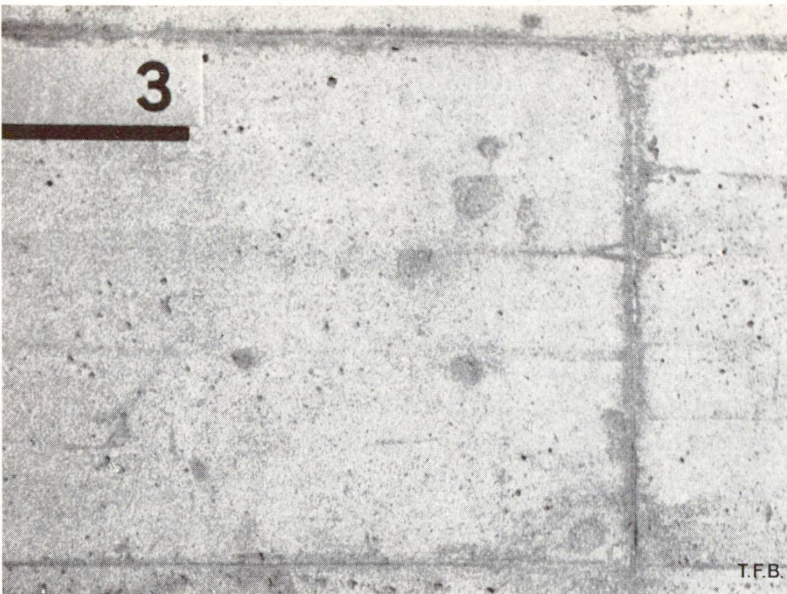
Abb. 5 und 6 Stützmauer mit Anzug wie Abb. 1 und 2. Aufnahmen 1962 bzw. 1972. Gut verdichteter Beton P 300 aus imprägnierten Schalntafeln. Allgemeine Dunklerfärbung infolge Bewuchses und Auflösung der obersten Kalkhaut. Anfänglich dunkle Streifen entlang der Schalungsfugen zeichnen heute hell. Dies ist die Folge der Nachhydratation und des geringeren Bewuchses der an diesen Stellen äusserst dichten und zementreichen Betonoberfläche. Zahlreich sind auch die scheinbar neuen Luftlöcher, die aber ursprünglich nur durch eine dünne Zementhaut bedeckt waren. Die Abzeichnungen der Holzäste treten heute stärker hervor als ursprünglich. Dies ist die Folge des stärkeren Bewuchses an Stellen grösserer Porosität. Ähnliches gilt auch für die scharfe Abzeichnung undichter Schalungsfugen. Der markante Flecken im unteren Eck der Schalungstafel ist komplexer Natur. Astholz, Undichtigkeit und Entmischung haben hier eine besonders starke Porosität des Zementsteins hervorgerufen.
