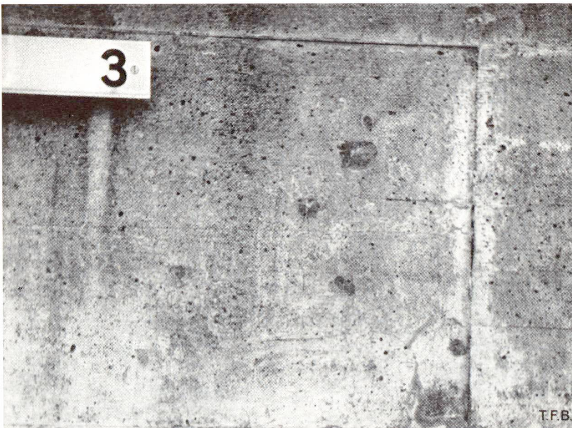
Abb. 5 und 6 Stützmauer mit Anzug wie Abb. 1 und 2. Aufnahmen 1962 bzw. 1972. Gut verdichteter Beton P 300 aus imprägnierten Schalungstafeln. Allgemeine Dunklerfärbung infolge Bewuchs und Auflösung der obersten Kalkhaut. Anfänglich dunkle Streifen entlang der Schalungsfugen zeichnen heute hell. Dies ist die Folge der Nachhydratation und des geringeren Bewuchses der an diesen Stellen äusserst dichten und zementreichen Betonoberfläche. Zahlreich sind auch die scheinbar neuen Luftlöcher, die aber ursprünglich nur durch eine dünne Zementhaut bedeckt waren. Die Abzeichnungen der Holzäste treten heute stärker hervor als ursprünglich. Dies ist die Folge des stärkeren Bewuchses an Stellen grösserer Porosität. Ähnliches gilt auch für die scharfe Abzeichnung undichter Schalungsfugen. Der markante Flecken im unteren Eck der Schalungstafel ist komplexer Natur. Astholz, Undichtigkeit und Entmischung haben hier eine besonders starke Porosität des Zementsteins hervorgerufen.
