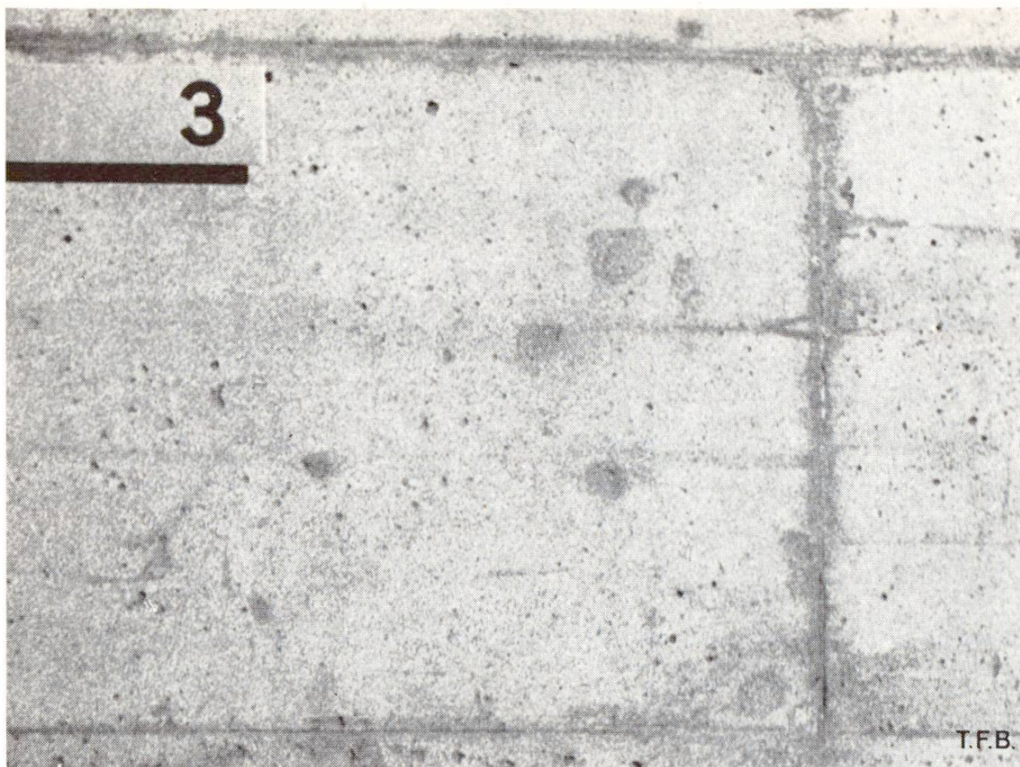
Abb. 5 und 6 Stützmauer mit Anzug wie Abb. 1 und 2. Aufnahmen 1962 bzw. 1972. Gut verdichteter Beton P 300 aus imprägnierten Schaltafeln. Allgemeine Dunklerfärbung infolge Bewuchs und Auflösung der obersten Kalkhaut. Anfänglich dunkle Streifen entlang der Schalungsfugen zeichnen heute hell. Dies ist die Folge der Nachhydratation und des geringeren Bewuchses der an diesen Stellen äusserst dichten und zementreichen Betonoberfläche. Zahlreich sind auch die scheinbar neuen Luftlöcher, die aber ursprünglich nur durch eine dünne Zementhaut bedeckt waren. Die Abzeichnungen der Holzäste treten heute stärker hervor als ursprünglich. Dies ist die Folge des stärkeren Bewuchses an Stellen grösserer Porosität. Ähnliches gilt auch für die scharfe Abzeichnung undichter Schalungsfugen. Der markante Flecken im unteren Eck der Schalungstafel ist komplexer Natur. Astholz, Undichtigkeit und Entmischung haben hier eine besonders starke Porosität des Zementsteins hervorgerufen.
