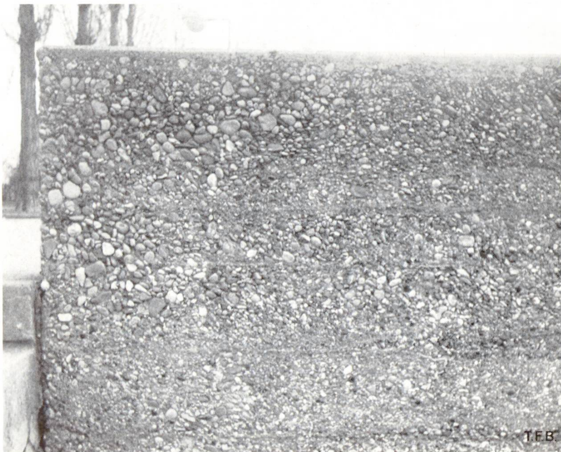
Abb. 9 und 10 Kleine Stützmauer aus Orts-Waschbeton in einer Schulhausanlage in Zürich, vollständig der Witterung ausgesetzt. Aufnahmen 1962 bzw. 1972. Dieses Bilddokument widerspricht der allgemeinen Auffassung, dass Waschbeton besonders frostgefährdet sei. Wohl sind die Körner heute, nach 10 Jahren, etwas mehr ausgewaschen und freigelegt, doch kaum ein Steinchen ist herausgesprengt worden. Auch die Mauerkrone aus einem Mörtelbelag hat sich sehr gut gehalten, im Gegensatz zum seitlichen Verputz der Treppenstufen.
