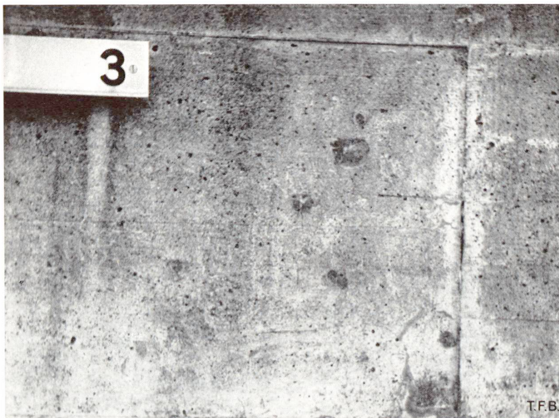
Abb. 5 und 6 Stützmauer mit Anzug wie Abb. 1 und 2. Aufnahmen 1962 bzw. 1972. Gut verdichteter Beton P 300 aus imprägnierten Schaltafeln. Allgemeine Dunklerfärbung infolge Bewuchs und Auflösung der obersten Kalkhaut. Anfänglich dunkle Streifen entlang der Schalungsfugen zeichnen heute hell. Dies ist die Folge der Nachhydratation und des geringeren Bewuchses der an diesen Stellen äusserst dichten und zementreichen Betonoberfläche. Zahlreich sind auch die scheinbar neuen Luftlöcher, die aber ursprünglich nur durch eine dünne Zementhaut bedeckt waren. Die Abzeichnungen der Holzäste treten heute stärker hervor als ursprünglich. Dies ist die Folge des stärkeren Bewuchses an Stellen grösserer Porosität. Ähnliches gilt auch für die scharfe Abzeichnung undichter Schalungsfugen. Der markante Flecken im unteren Eck der Schalungstafel ist komplexer Natur. Astholz, Undichtigkeit und Entmischung haben hier eine besonders starke Porosität des Zementsteins hervorgerufen.
