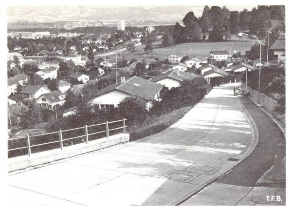
Abb. 2 Eine Hanglage bei Yverdon wurde 1961 durch diese Betonstrasse erschlossen, die sich in weiten Bögen dem Gelände anschmiegt. Erst diese feste Zufahrt ermöglichte den Bau der geplanten Einfamilienhäuser. Man beachte die Schächte zu den Abzweigungen oder Einmündungen von Anschlussleitungen.
