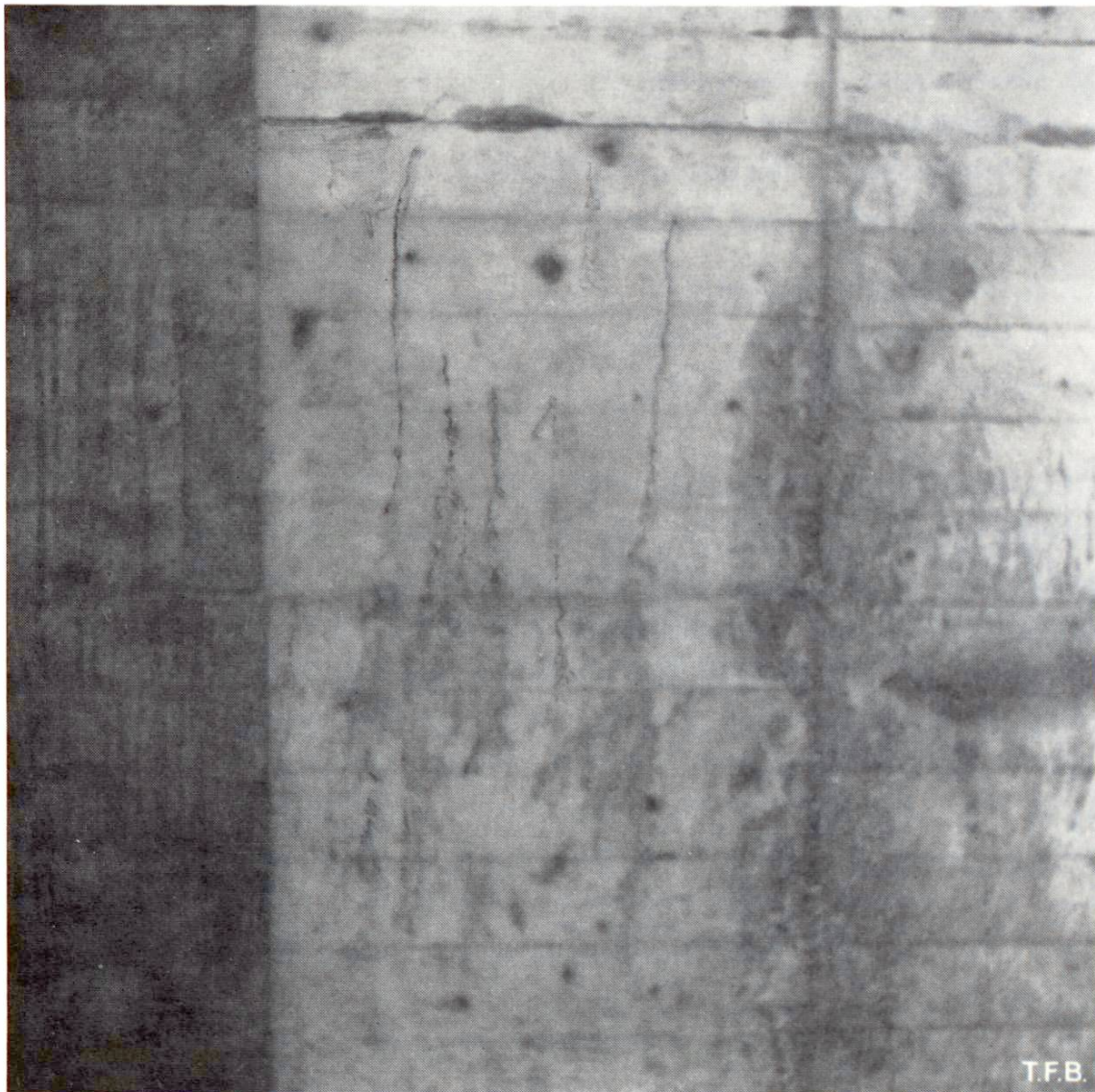
Abb. 2 Aufwärts gerichtete Rinnsuren und entsprechende Auswaschungen deuten auf eine vollständige Ausscheidung von Anmachwasser. Hydraulischer Kalk verbessert das Wasserrückhaltevermögen des Mörtels.
