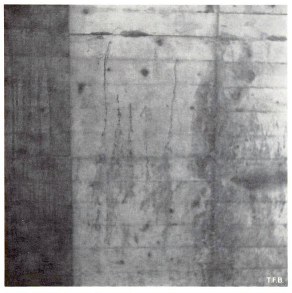
Abb. 2 Aufwärts gerichtete Rinnspuren und entsprechende Auswaschungen deuten auf eine vollständige Ausscheidung von Anmachwasser. Hydraulischer Kalk verbessert das Wasserrückhaltevermögen des Mörtels.
