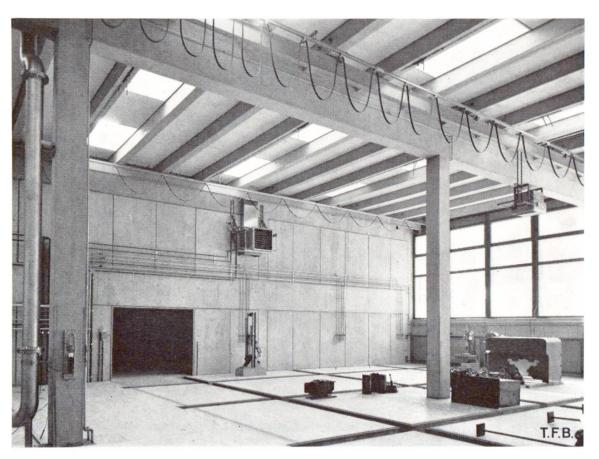
Abb. 3 Labortrakt Technikum. Vorne eine offene Achse des Tragskelettes aus Stützen und Trägern. Hinten eine ausgefachte Achse mit doppelten Platten und aufmontierten Leitungen und Apparaten.
