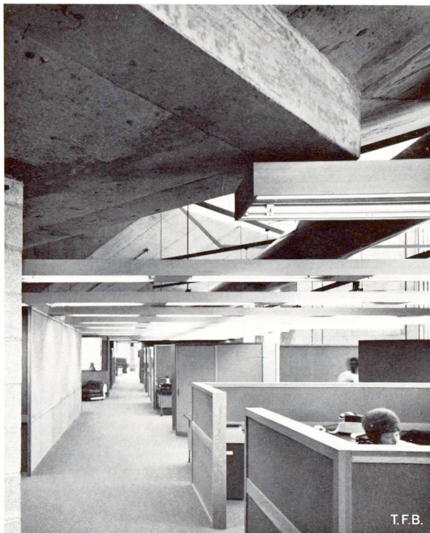
Abb. 3 Büros mit Teppichboden, verstellbaren Wandelementen aus Eichenholz und Kork und mit festen Wänden aus Betonstein-Mauerwerk. Die Installationen treten zurück, die bewegte Sichtbetondecke tritt deutlicher in Erscheinung.
