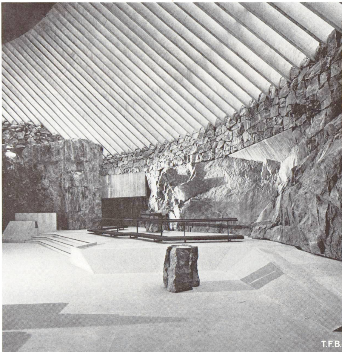
Abb. 7 Vom Taufstein zur Kanzel. Der Boden besteht aus Beton mit verschieden bearbeiteter Oberfläche.
