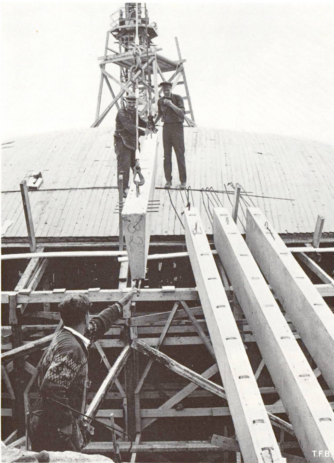
Abb. 4 Einsetzen der radialen Kuppelstützen. Vorfabrizierte Betonbalken verschiedener Länge.
