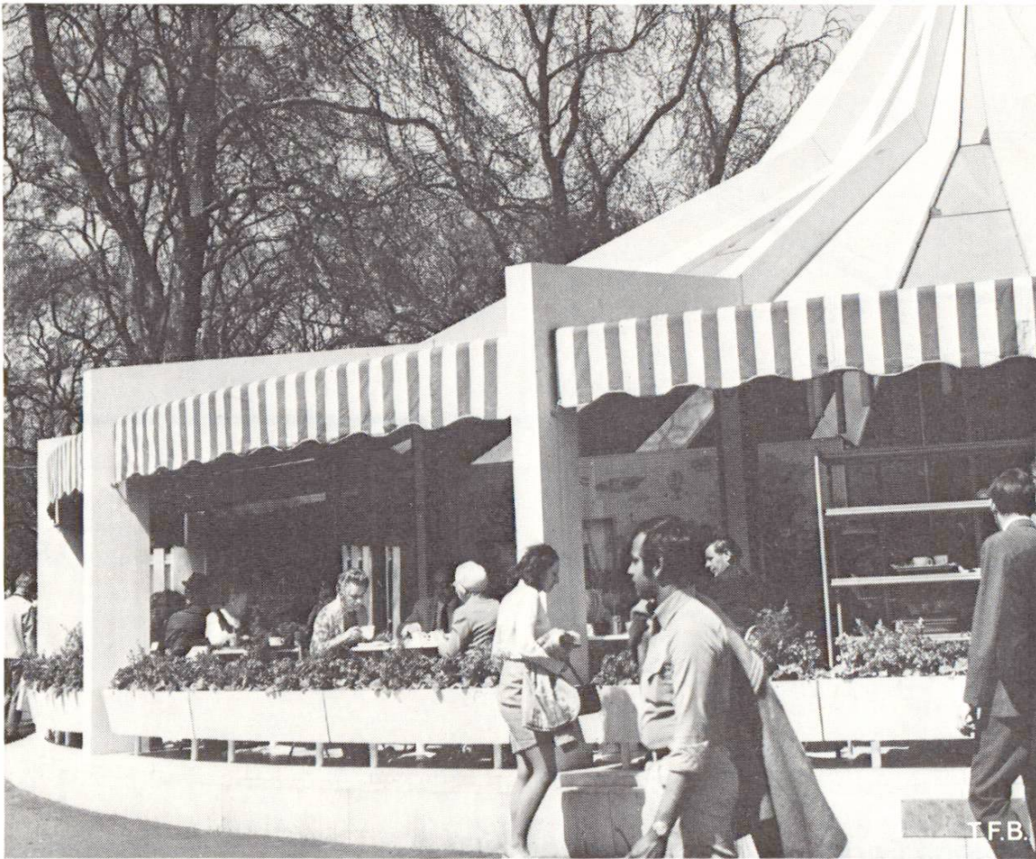
Abb. 3 Das kreisförmige Dach ist in 14 Segmente unterteilt. Die Betonteile sind mit weissem Portlandzement gefertigt und haben eine glatte Oberfläche. Zwischen den Segmenten sind Glasplatten eingefügt.
