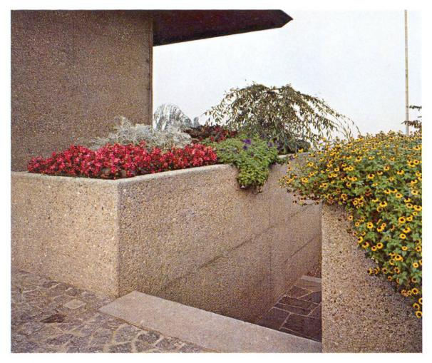
Durchgang zwischen Pflanzentrögen. Kleine Undichtigkeiten in den Schalungsfugen zeichnen sich bei entfernter Zementhaut eher noch stärker ab als beim schalungsrohen Sichtbeton.
