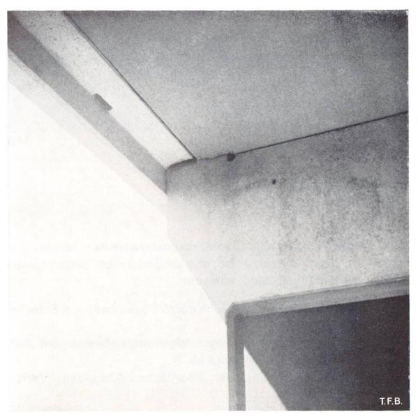
Abb. 6 Ungleichmässiger Auftrag von Schalungsöl auf Stahlschalung erzeugt Fleckenbildung.
