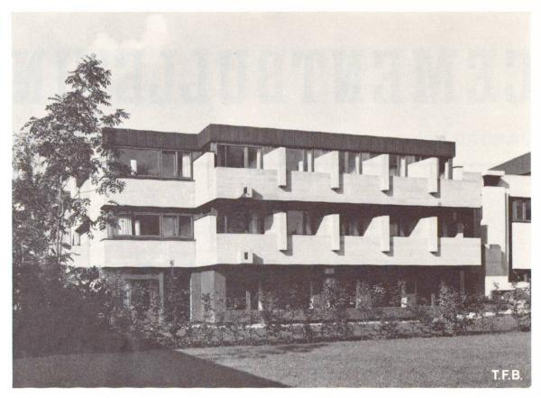
Abb. 1 Paulus-Akademie, Zürich-Witikon Sichtbeton mit Leca zusammengesetzt wie im Text erwähnt Zementdosierung 320 kg/m³, Aussenwände 35 cm (Architekt Dr. J. Dahinden, Zürich, Ingenieur Desserich & Funk, Luzern)
