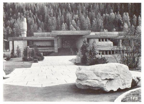
Abb. 4 Hallenbad in St. Moritz Leca-Sichtbeton wie im Text angegeben, Zementdosierung 350 kg/m³, Aussenwände 60 cm (Architekt R. Obrist & A. Theus, St. Moritz, Ingenieur Jenatsch & Hegland, Chur)
