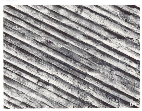
4 Das Problem, der Betonoberfläche ein angenehmeres, wärmeres Aussehen zu geben, stellt sich besonders auch bei der Vorfabrikation. Mehr und mehr sieht man Fassadenplatten als Waschbeton ausgeführt. Diese lassen sich im Betonwerk verhältnismässig gut herstellen, doch das Verfahren bleibt recht aufwendig. Anzustreben sind ornament- oder rasterartige Einprägungen, die auf einfache Weise direkt beim Guss erzeugt werden. Diese Aufgabe harrt noch der vollkommenen Lösung.
