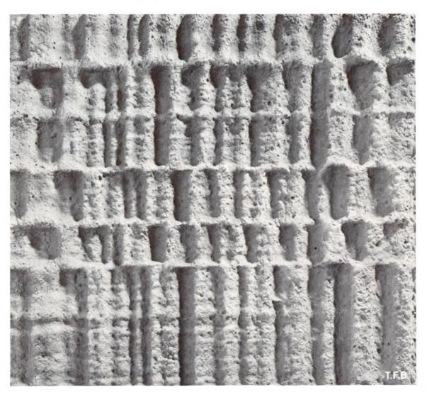
7 handlung und Reinigung der Bretter erübrigen. Die Schaumstofftafel, die beim Ausschalen zunächst am Beton haften bleibt, dient dann auch als Schutz gegen Frost, Beschädigung und Verschmutzung während der Rohbauperiode.
