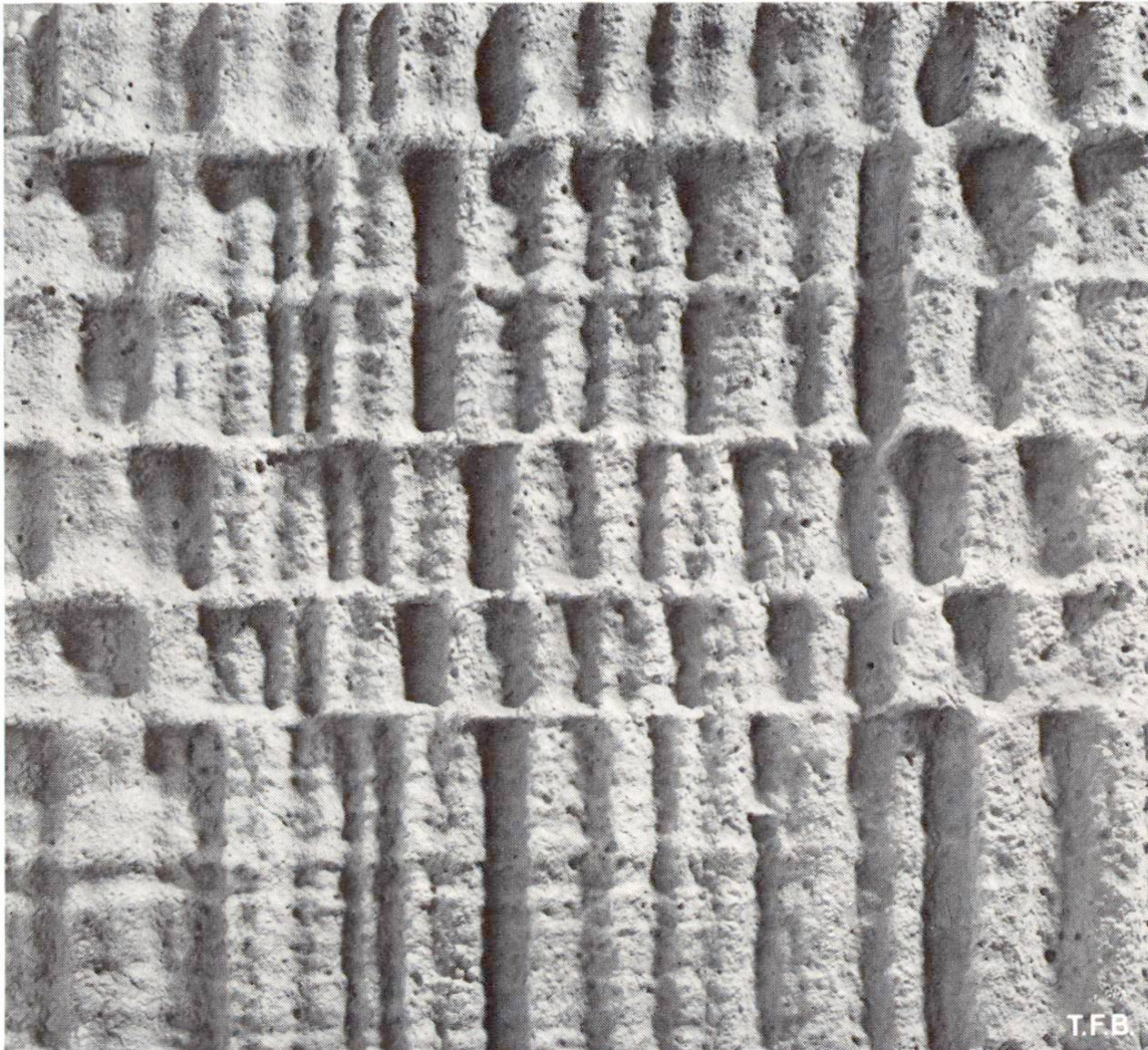
Abb. 6 Ornamentartige Zeichnung aus einer «Prewi»-Schalung. Sieben verschiedene Strukturen stehen zur Verfügung, weitere sind in Vorbereitung.
