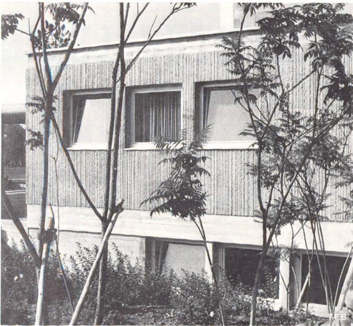
Abb. 1 Schulhaus Hegifeld, Oberwinterthur, 1963. Hier wandte Z. Pregowski erstmals seine Idee des strukturierten Sichtbetons an. Die Schalung wurde inwendig mit Armierungseisen belegt, die sich im Beton einprägten.
