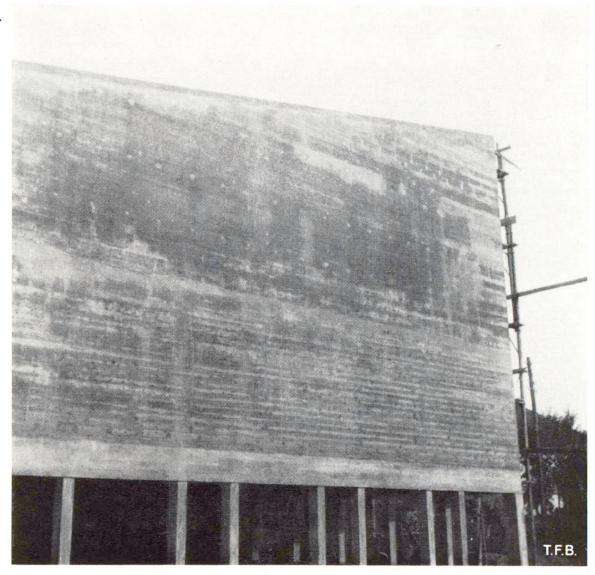
Abb. 3 Eine grosse, zusammenhängende Sichtbetonfläche bietet besondere Schwierigkeiten. Diese hier ist missraten wegen Zementhautablösung infolge «Schüsseln» der Schalungsbretter (Abb. 2, Mitte) und im oberen Teil infolge chemischer Beeinträchtigung der Betonoberfläche durch vergilbtes Schalungsholz. Die Schalung stand zu lange offen, wurde ungenügend vorbehandelt und vor dem Betonieren nicht genässt.
