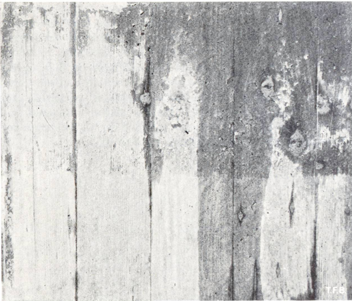
Abb. 4 Zementhautablösung infolge «Schüsseln» der Schalungsbretter (3. und 4. Brett von links, schematische Darstellung des Vorganges: Abb. 2, Mitte). Im oberen Teil erkennt man Zementhautablösung als Folge einer geringen Verschiebung gegenüber der Schalungsfläche wegen sich setzendem Beton (unstabile Schalung)
