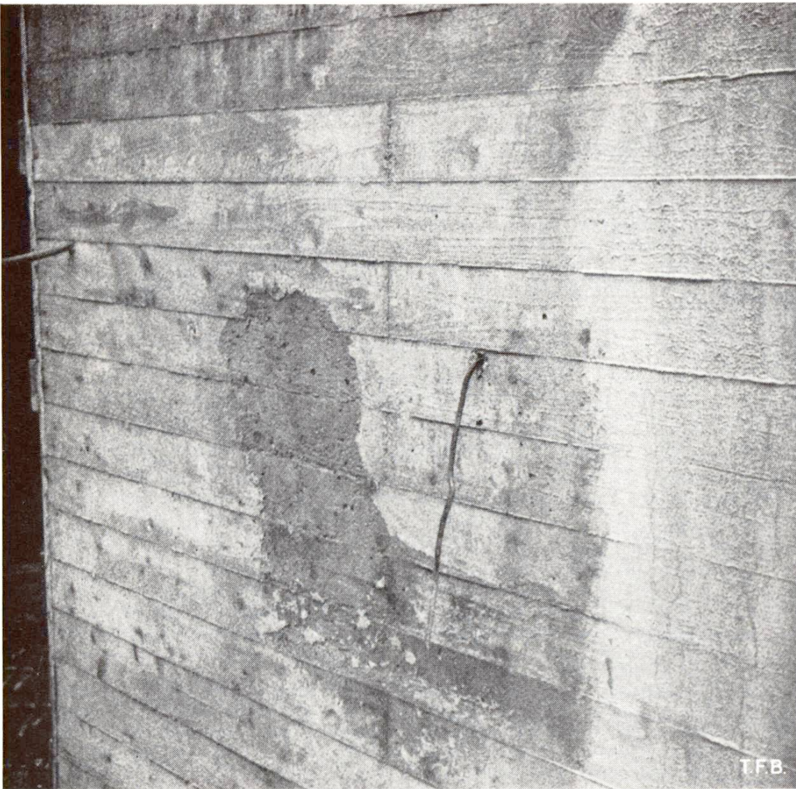
Abb. 6 Starke Zementhautablösung infolge Vibratorwirkung in einer schon zu stark verfestigten Schicht.
