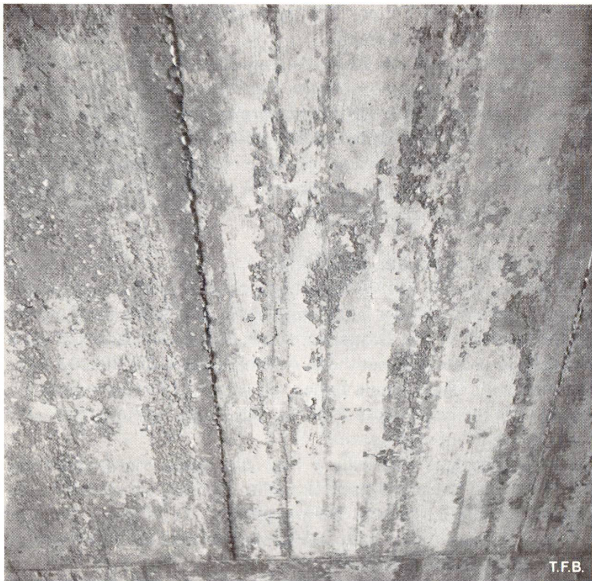
Abb. 7 Starke Zementhautablösung an der Untersicht einer Decke infolge Schwächung des Zementsteins bei Wasseranreicherung (Entmischung zwischen Zement und Wasser an der Schalungsfläche).
