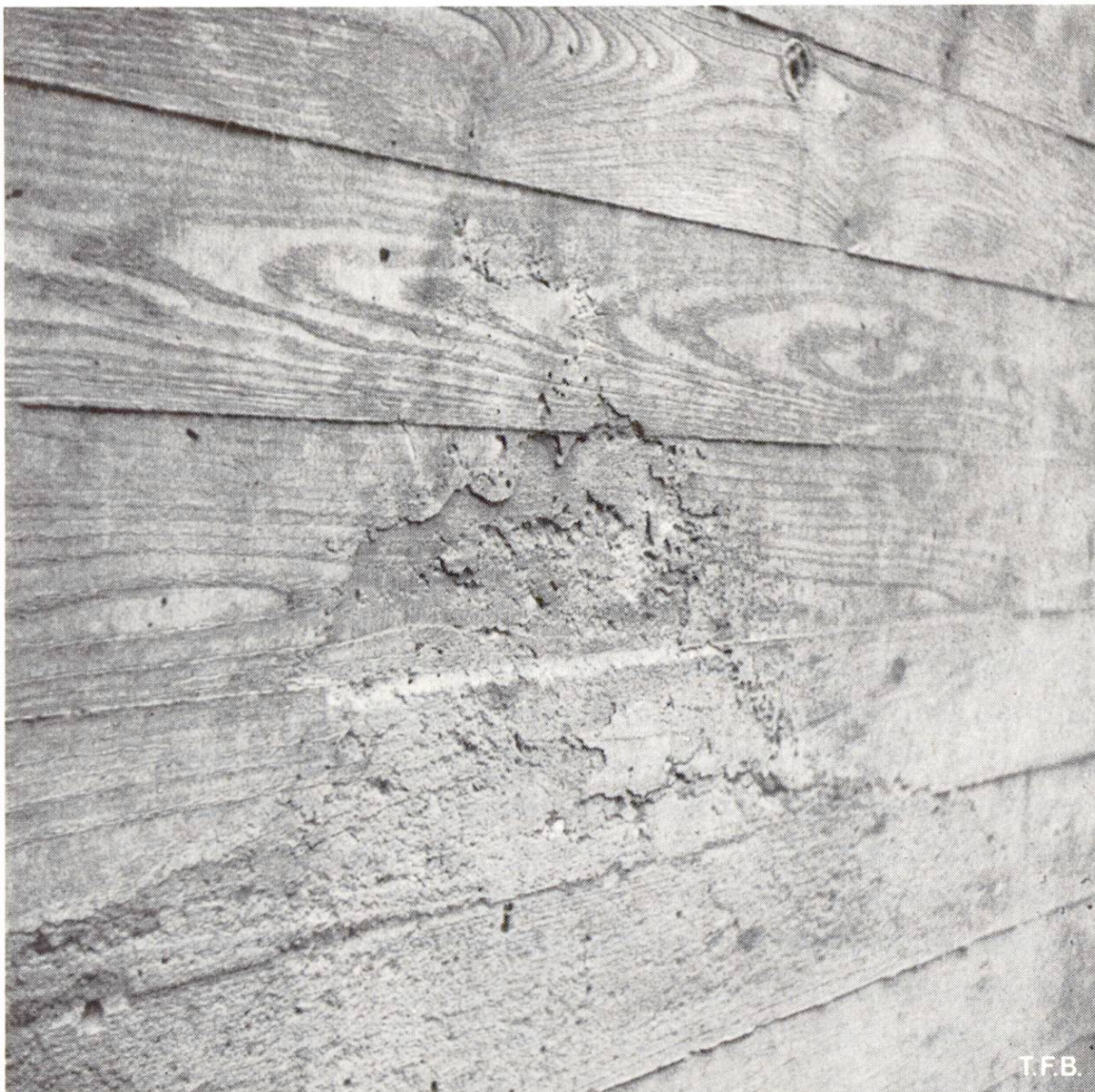
Abb. 5 Massive Zementhautablösung durch Wegdrücken der Schalung beim Einbringen und Verdichten der überliegenden Schicht (unstable Schalung, evtl. untere Schicht schlecht verdichtet).
