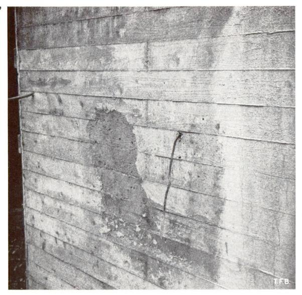
Abb. 6 Starke Zementhautablösung infolge Vibratorwirkung in einer schon zu stark verfestigten Schicht.
