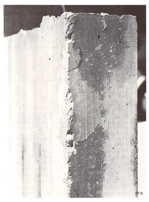
Abb. 1 Nahaufnahme einer typischen Zementhautablösung. Das Schalungsbrett der Stirnseite wurde durch die quellenden Bretter der Frontseite frühzeitig weggedrückt. Man beachte auch die aus diesem Grunde beschädigte Kante. Schematische Darstellung des Vorganges s. Abb. 2
