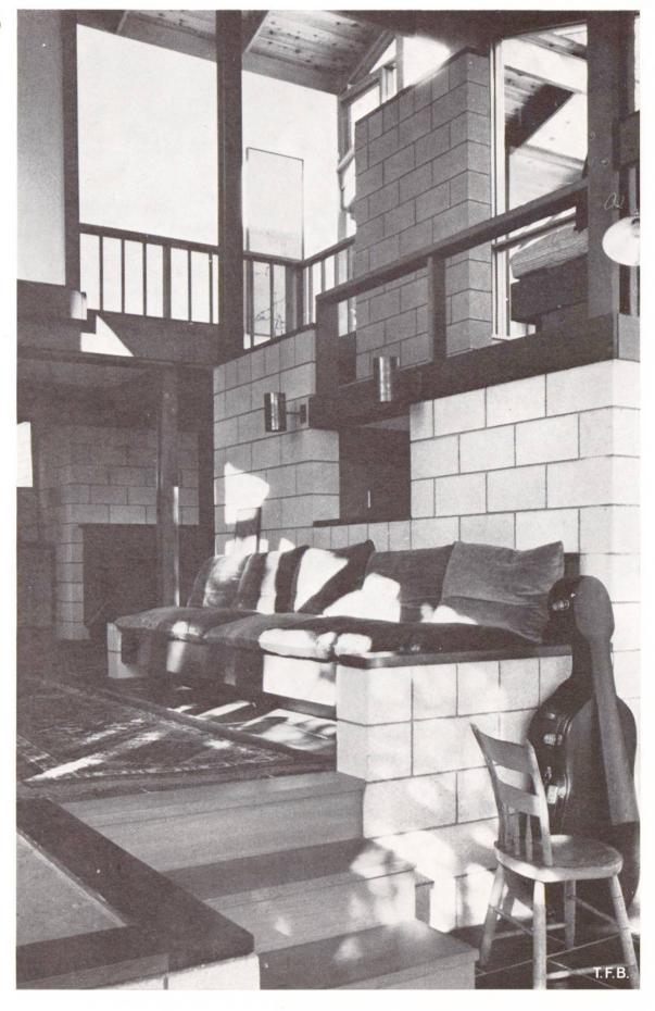
6 Formen. Der Beton-Formstein führt zu einer eigenständigen Architektur, die nur im Entfernten an altertümliches Gemäuer erinnert. Die Eigenart kommt deutlich zum Ausdruck mit der sich unerbittlich aufdrängenden Massordnung und bei der Gestaltung von «liegenden» Bauteilen, für die konsequenterweise andere Materialien gewählt werden.
