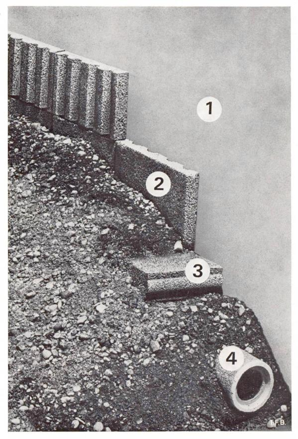
Abb. 5 Schematisch gezeigter Aufbau einer Wanddrainage mit Sickerplatten.
