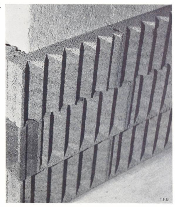
Abb. 4 Aufbau einer Sickerwand mit zickzackförmigem Querschnitt.
