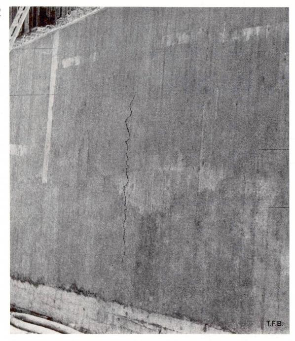
Abb. 1 Temperatur-Spaltriss in einer 80 bis 110 cm dicken Schwergewichts-Stützmauer (Riss leicht nachgezogen).
