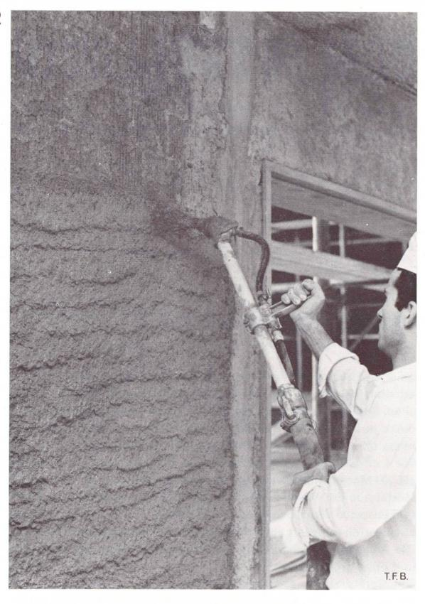
Abb. 1 Das Arbeitsgerät des maschinellen Putzauftrages. Man erkennt die dicke Schlauchleitung für die Zuführung des Mörtels und den dünneren Schlauch für die Druckluft. Mit der Düse wird der Mörtel mittelst der ausströmenden Luft stark beschleunigt und an die Wand geworfen.
