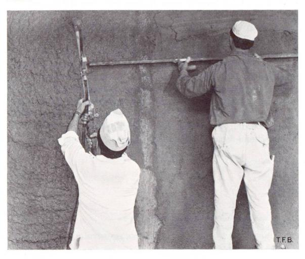
4 einem Maschinisten, einem Anwerfer und zwei bis drei Mann zum Abziehen und Fertigmachen. Ein Gehilfe zieht die Schläuche nach und steht dem Maschinisten zur Verfügung.
