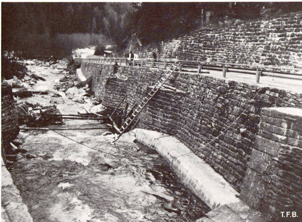
Abb. 5 Gefüllter Colcrete-Container am Stützmauerfuss nach dem Entfernen der Hilfschalung.
