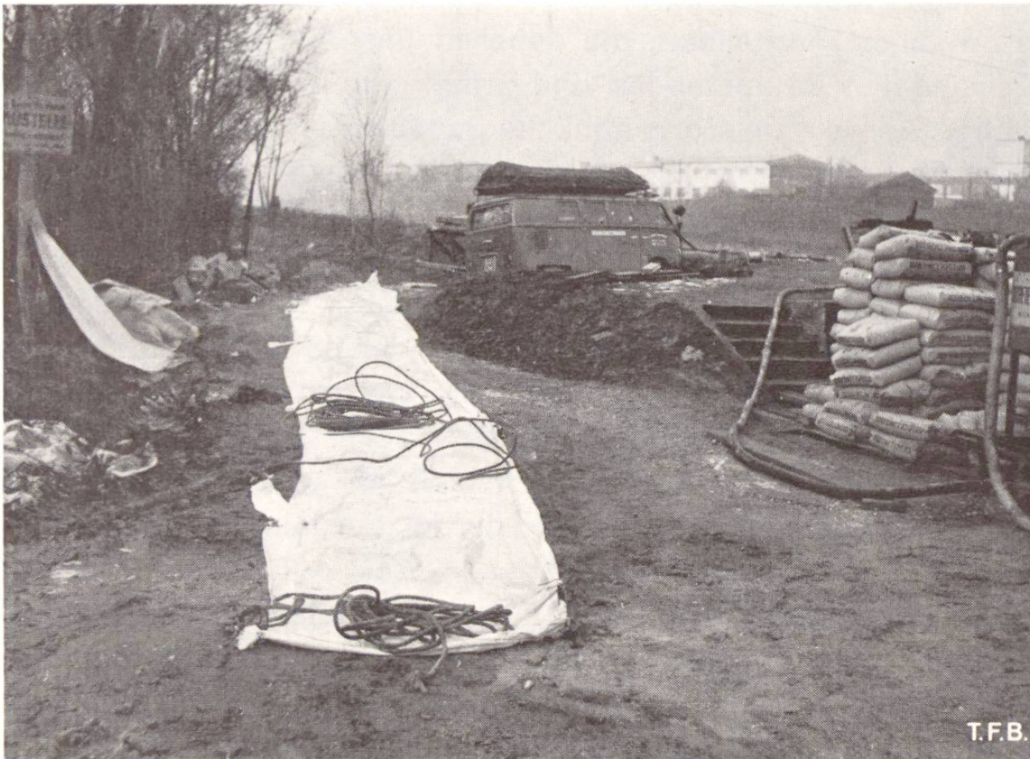
Abb. 1 Colcrete-Container vor dem Verlegen, Gewebehülle von 1,50 m Breite und 20 m Länge.
