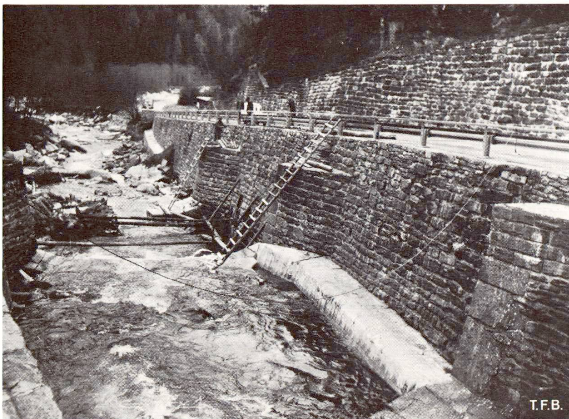
Abb. 5 Gefüllter Colcrete-Container am Stützmauerfuss nach dem Entfernen der Hilfs-schalung.
