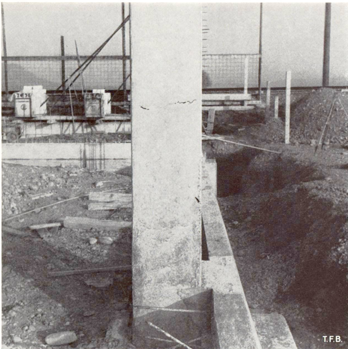
Abb. 6 Nachgebende Schalung im unteren Teil (Ausbuchtung) verursacht darüber klaffende Setzungsrisse (Lunkerbildung).
