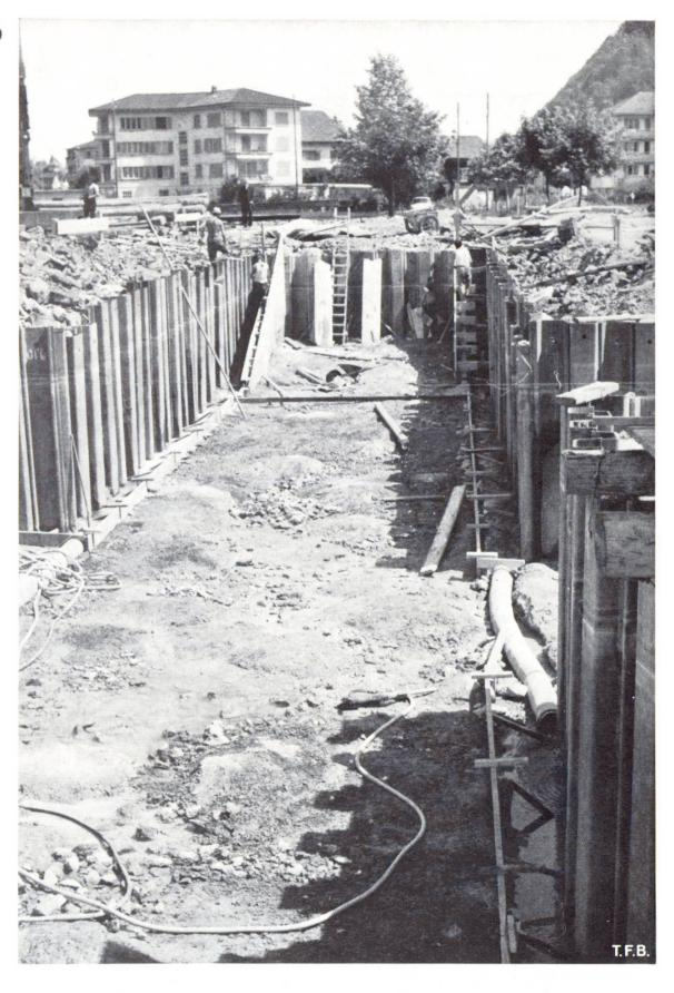
Abb. 7 Fussgänger-Unterführung: Aufsicht auf Unterwasserbetonplatte, Unebenheit etwa 20 cm.
