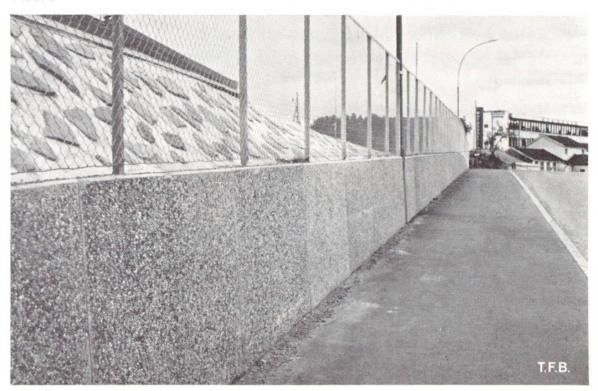
3 In der letzten Zeit hat man deshalb als Auflager eine durchgehende armierte Sohle betoniert, an deren Hinterkante vertikale Anschlusseisen angeordnet sind, die über die Elementsohle herausragen und einbetoniert werden. Es ist ratsam der Mauer einen Anzug von ungefähr 1:10 zu geben. Weil die Winkelstützmauerelemente rechtwinklig sind, muss dann das Auflager eine entsprechende Neigung erhalten.
