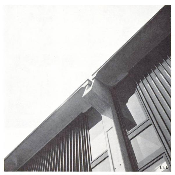
Abb. 5 Detail der Fassadenkonstruktion. Ausfachung mit Aluminium-Glaskonstruktion.
