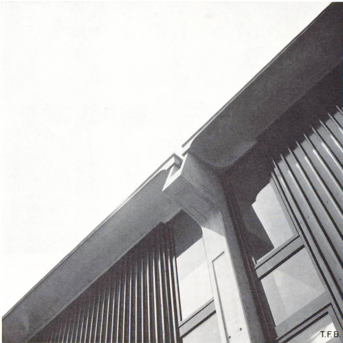
Abb. 5 Detail der Fassadenkonstruktion. Ausfachung mit Aluminium-Glaskonstruktion.
