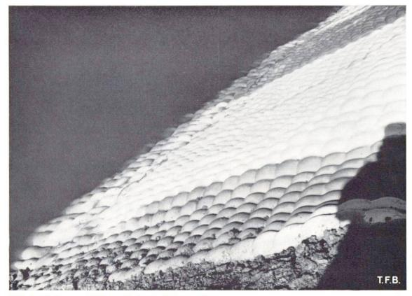
Abb. 9 Seitenansicht der Colcrete-Betonmatten.
