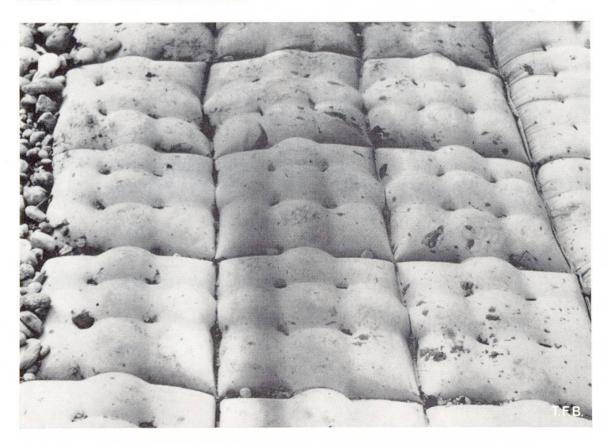
Abb. 5 Flexible Colcrete-Betonmatte.
