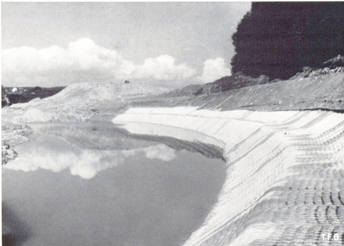
Abb. 10 Gesamtansicht der Baustelle.
