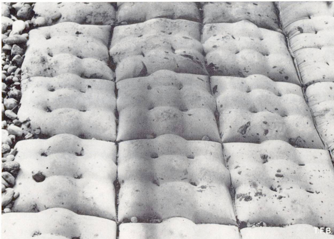
Abb. 5 Flexible Colcrete-Betonmatte.
