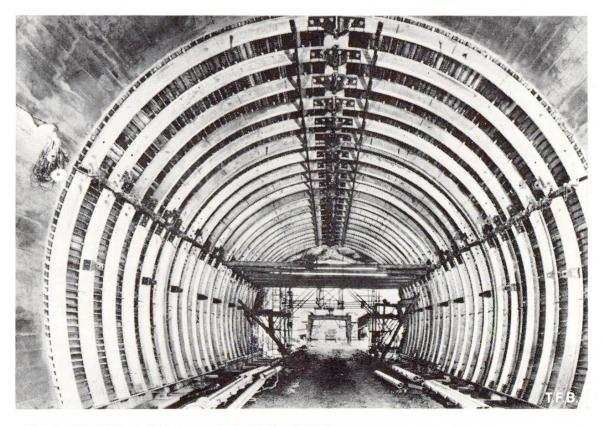
Abb. 5 Aluminium-Schalungselemente im Einsatz.
