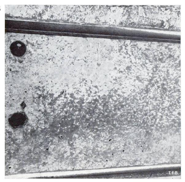
Abb. 10 Ungleichmässige Kalkausscheidungen infolge veränderlichem Wasserzementwert. Kleine Sprenkelung: Iokale kleine Entmischungen des Zementleims, grossflächige Farbdifferenzen: ungleiche Mischung oder Verdichtungsarbeit.
