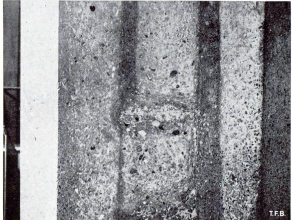
Abb. 6 Bei undichten Stellen der Schalung bilden sich im Beton die bekannten Abmagerungen, die ihrerseits meistens von dunklem und sehr kompaktem Zementstein umgeben sind. Der Wasserzementwert ist in diesem Bereich stark herabgesetzt. Dieses Bild zeigt eine derartige Wirkung bei undichten Bretterfugen, und zwar in etwa 1 cm Tiefe (der Beton wurde geschliffen).
