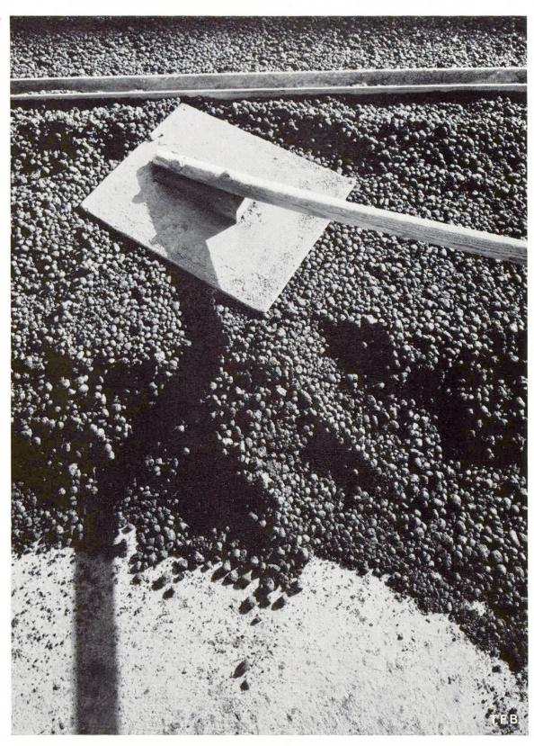
Abb. 9 Verdichten von Leca-Isolationsbeton.
