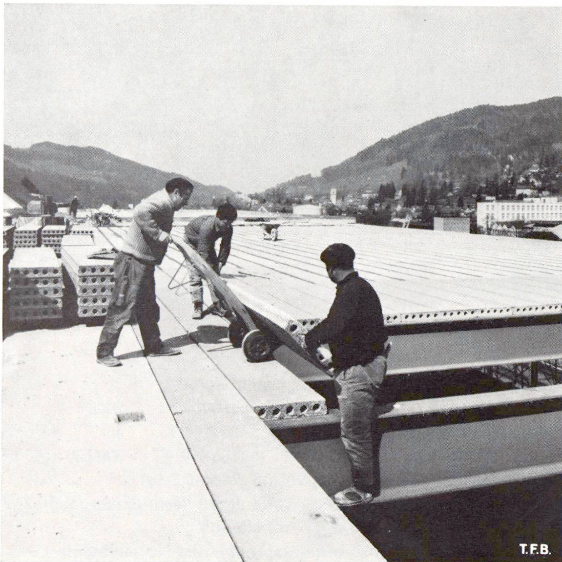
Abb. 8 Dachplatten als Beispiel für die Anwendung von Leichtbeton in der Vorfabrikation.
