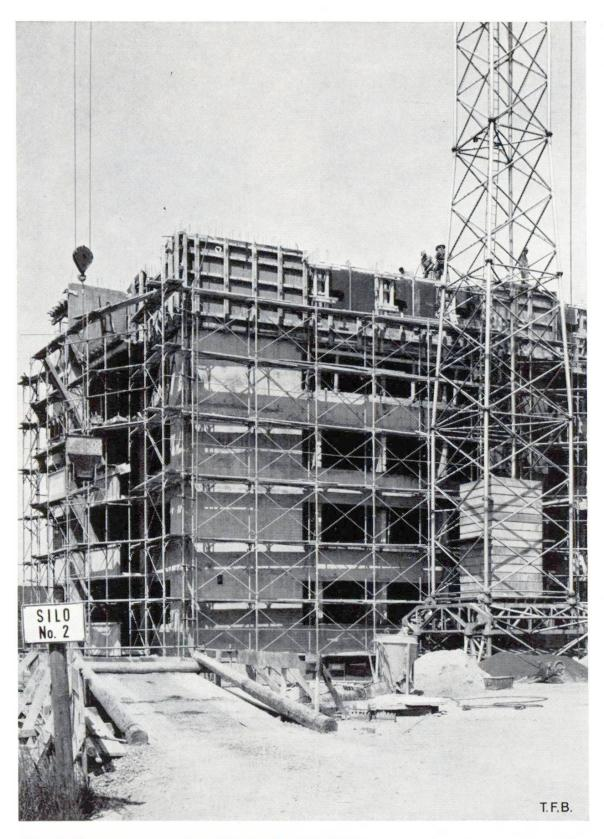
Abb. 6 Wohnungsbau mit Leichtbeton (Schüttbeton).
