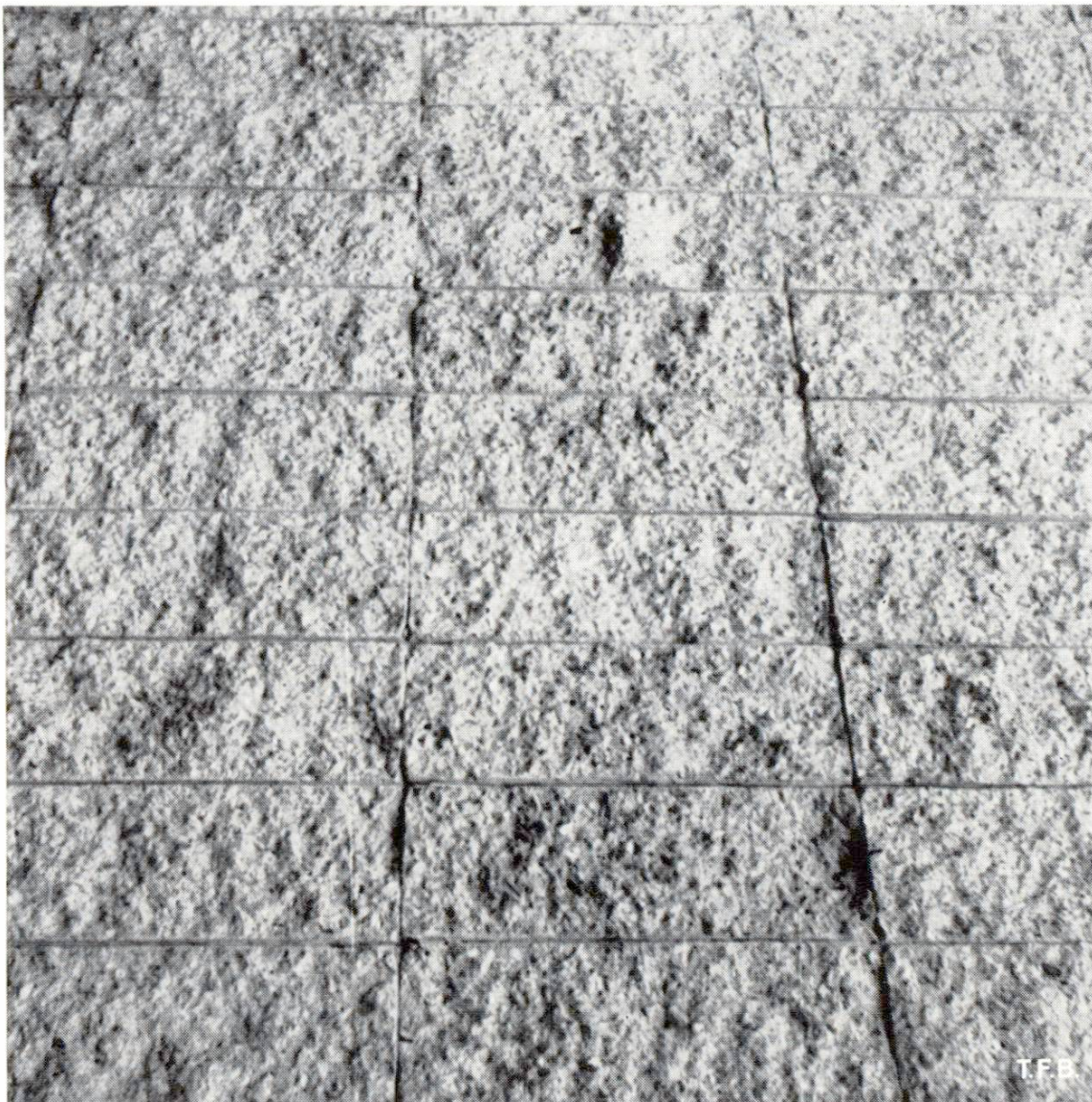
Abb. 4 Sichtmauerwerk mit sehr dünnen Lager- und Stossfugen.
