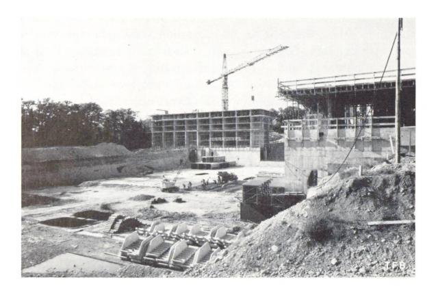
Abb. 5 Rohbau eines Teils des langgezogenen Gebäudes (Abb.1, unten rechts). Jedes vierte Stockwerk ist wenig zurückgesetzt. Es enthält Waschküchen, Trockenräume, Abstellräume und Kleinwohnungen. Die Fassade wird als Vorhängekonstruktion mit Aluminium-, Glas- und Isolierstoffelementen ausgeführt.
