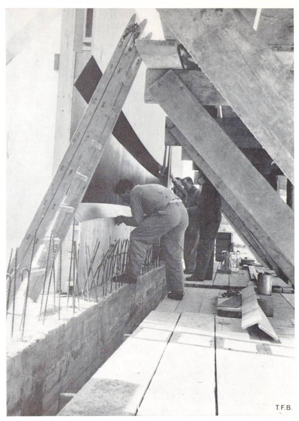
tisch-regelmässiges Verdichten mit Innenrüttlern konnte eine gleichmässige und fehlerfreie Oberfläche erzielt werden. Dazu hat auch die gründliche Kontrolle der Schalung auf allfällige Undichtigkeiten beigetragen. Nach dem Ausschalen nach 6 Tagen zeigte es sich, dass keine Reparaturen oder Retouchen notwendig waren. Das Werk ist in allen Teilen gut gelungen. Es wirkt durch die Kraft
