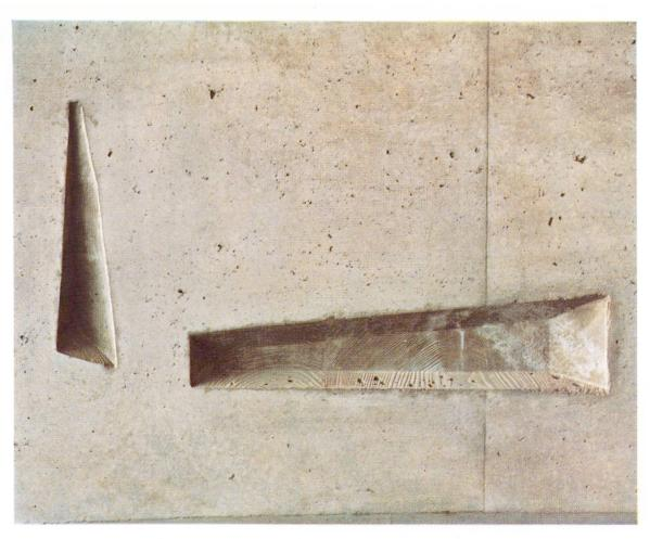
eine vorstehende Braue entstehen liessen. Die figürlichen vorspringenden Betonteile wurden mit glatten, kunststoffbeschichteten Sperrholzplatten geschalt. Dieses Material lässt sich sehr gut zurechtschneiden, biegen und schleifen. Eine solche Schalung herzustellen war gewiss auch ein handwerkliches Meisterstück. Der Künstler hat es sich nicht nehmen lassen, dabei selber Hand anzulegen.
