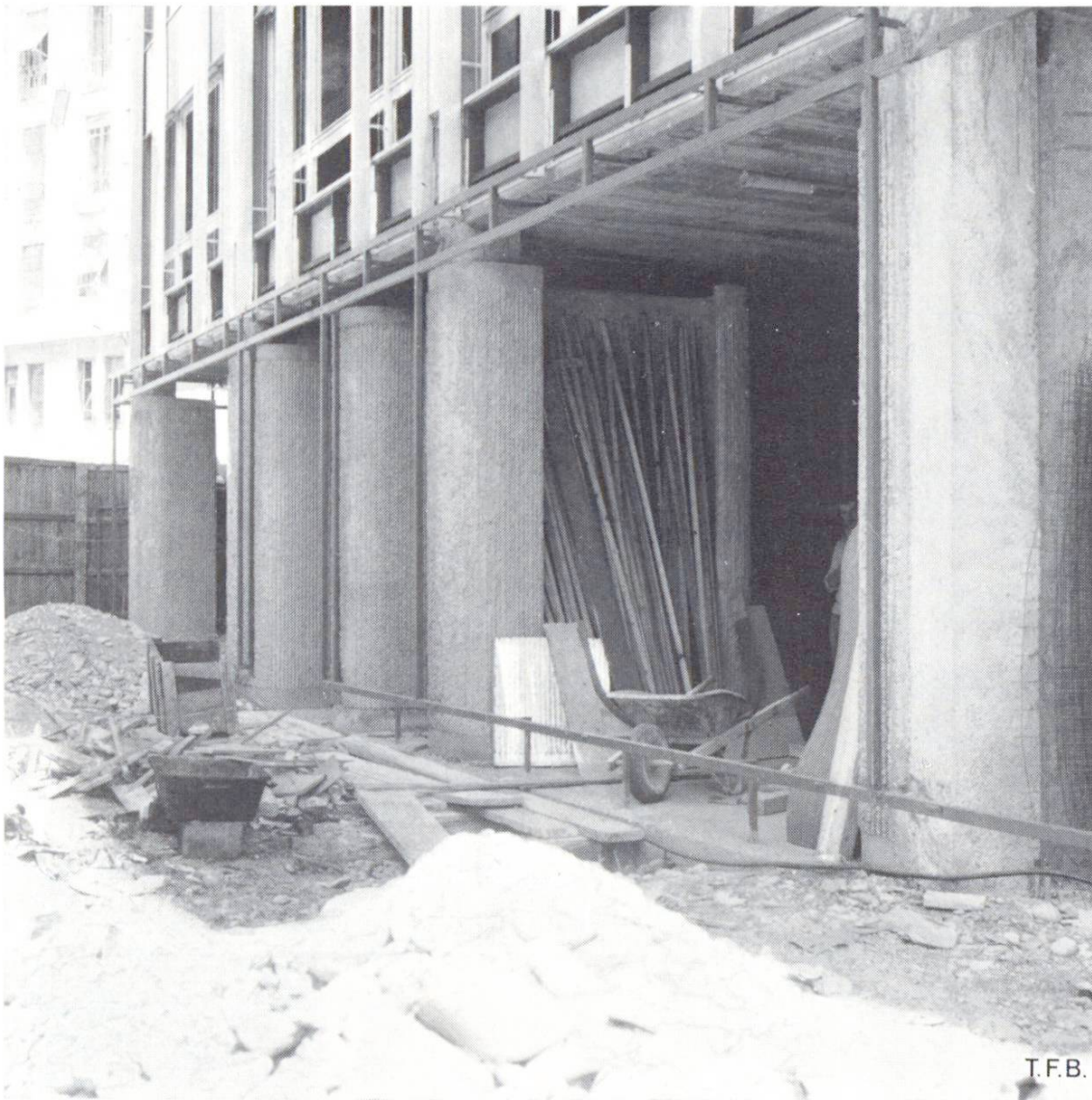
Abb. 4 Eine Schaufensterfront im Rohbau-Zustand.
