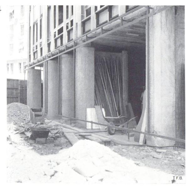
Abb. 4 Eine Schaufensterfront im Rohbau-Zustand.
