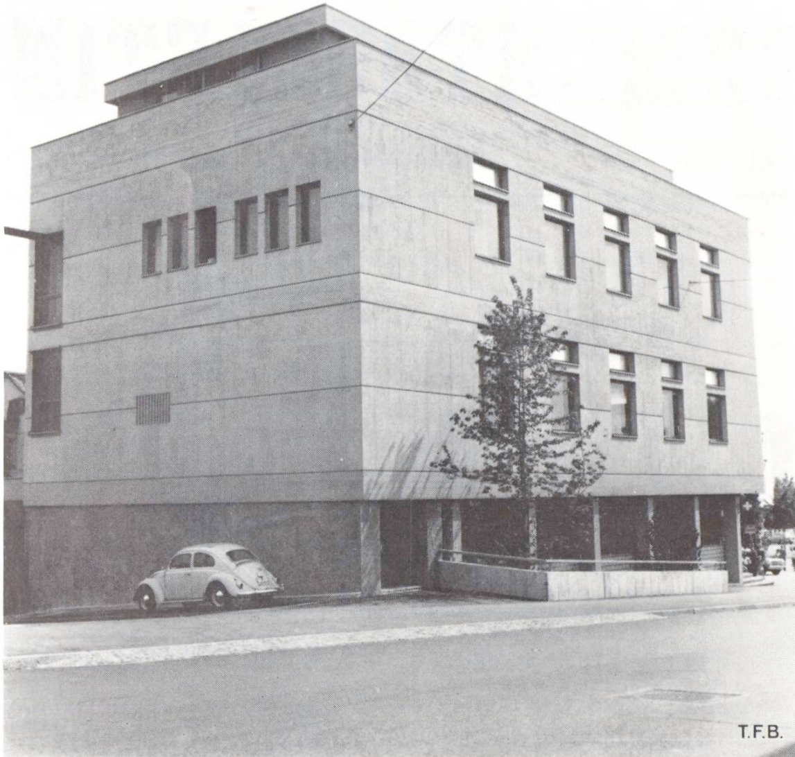
Abb. 10 Sichtbetonbau mit scharf zeichnenden Arbeitsfugen.
