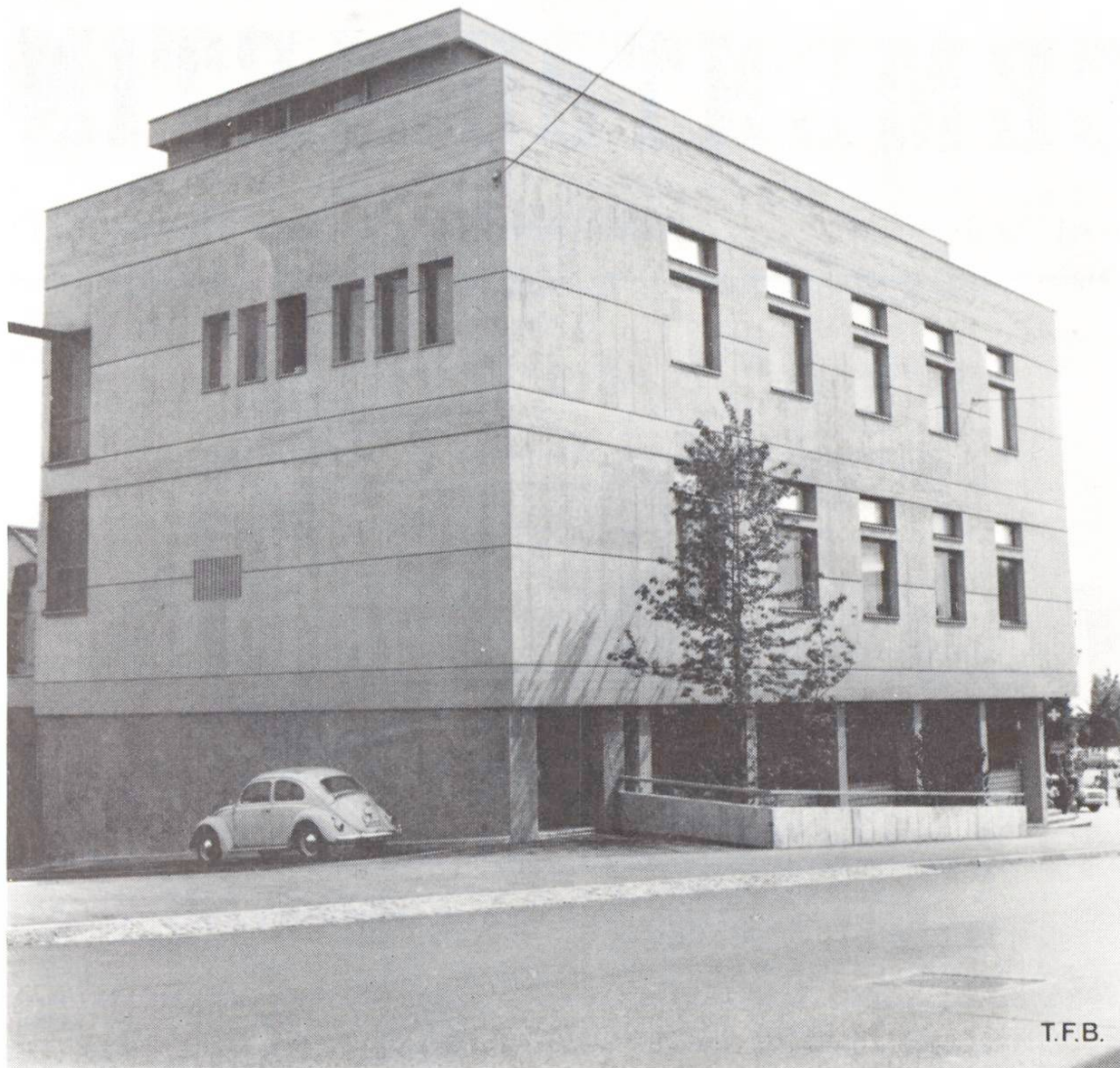
Abb. 10 Sichtbetonbau mit scharf zeichnenden Arbeitsfugen.
