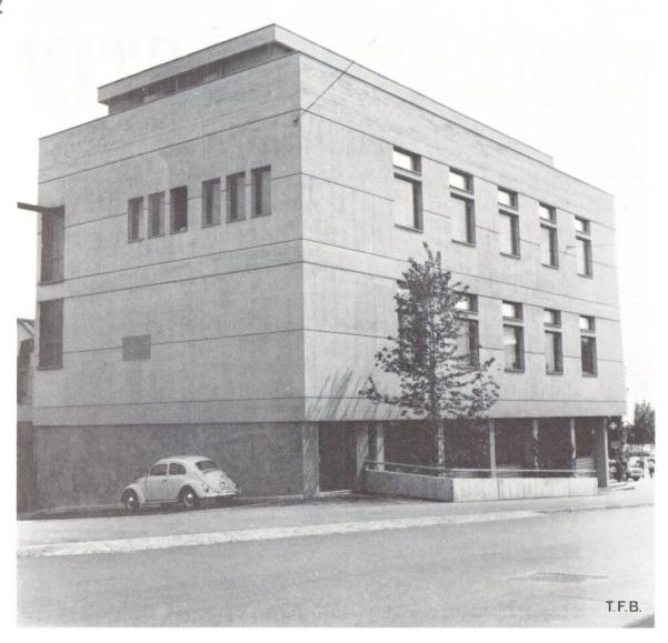
Abb. 10 Sichtbetonbau mit scharf zeichnenden Arbeitsfugen.
