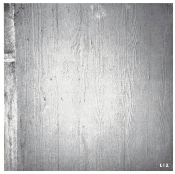
Abb. 4 Sichtbeton aus roher Bretterschalung.
