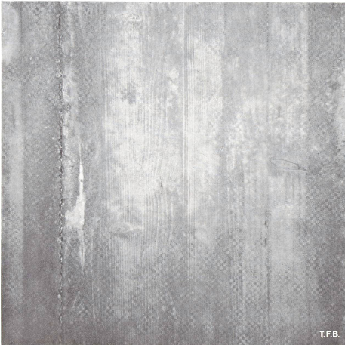
Abb. 5 Sichtbeton aus vorgefertigten Schalttafeln.
