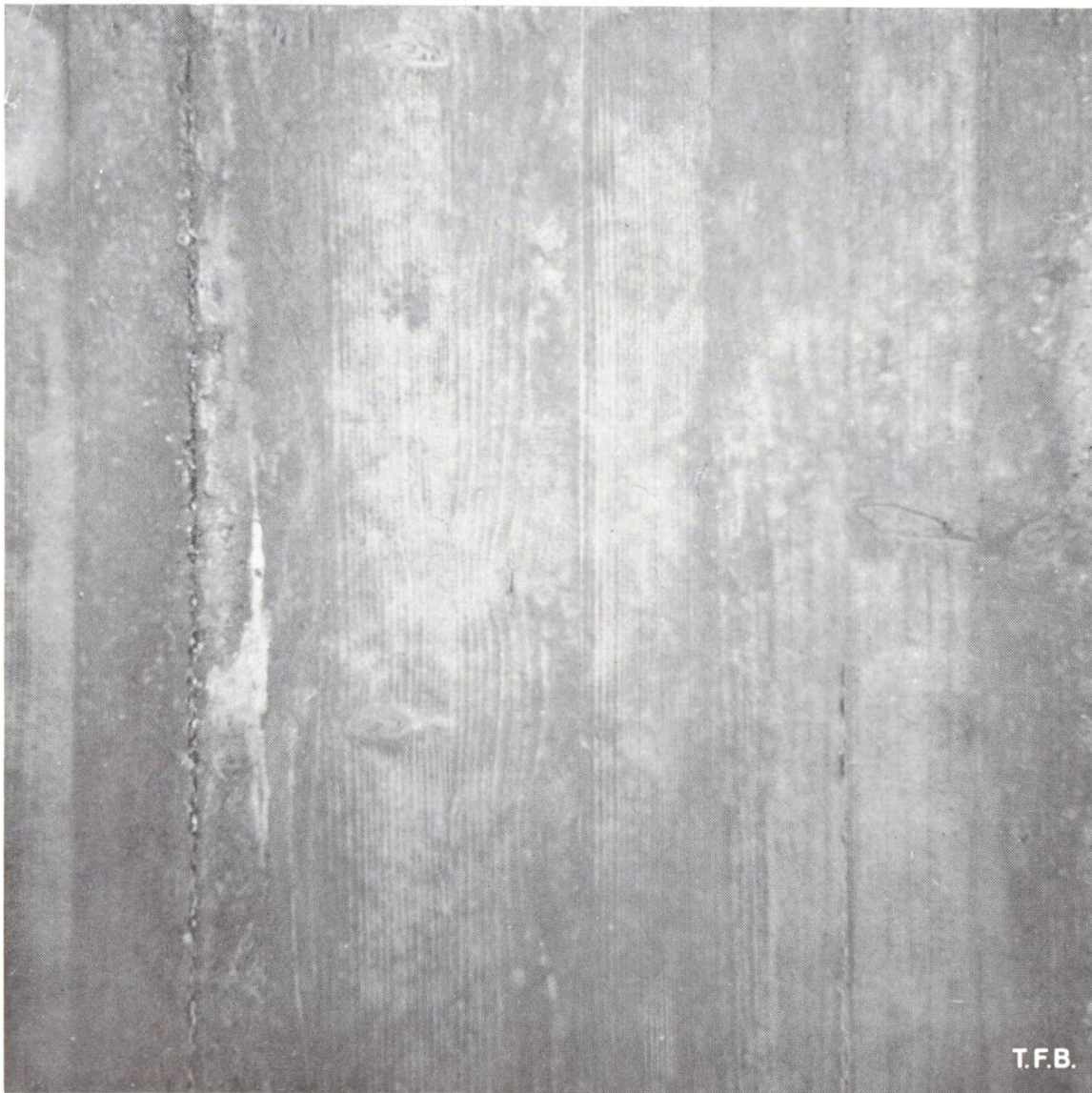
Abb. 5 Sichtbeton aus vorgefertigten Schaltafeln.
