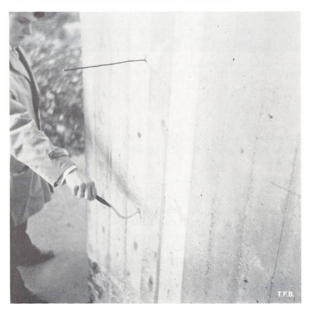
7 Antwort: «Am wichtigsten ist die Stabilität der Schalung. Mit Querhölzern und Longarinen sollte nicht gespart werden, besonders bei Mauern und Pfeilern mit geringer Stärke. Viele Fehler wie ungleiche Mauerstärke, krumme Sichtflächen, undichte An-
