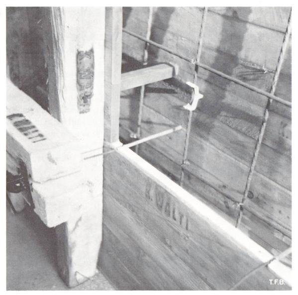
Abb. 6 Aufbau einer Sichtbetonschalung mit Schaltafeln und eingelegten Gipslatten-Streifen. Man erkennt einen in einem Gummischlauch steckenden Bindedraht.
