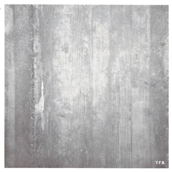
Abb. 5 Sichtbeton aus vorgefertigten Schaltafeln.
