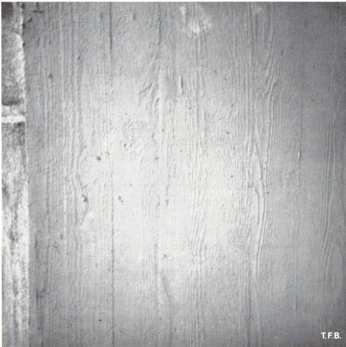
Abb. 4 Sichtbeton aus roher Bretterschalung.
