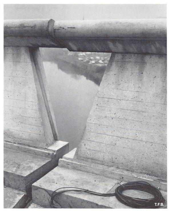
Abb. 5 Bild des Treffpunktes der beiden Brückenteile unmittelbar nach dem Drehprozess und vor der endgültigen Einnivellierung und Befestigung.
