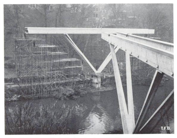
Abb 2. Vorbereitungen für das Einschwenken des zweiten Brückenteils.
