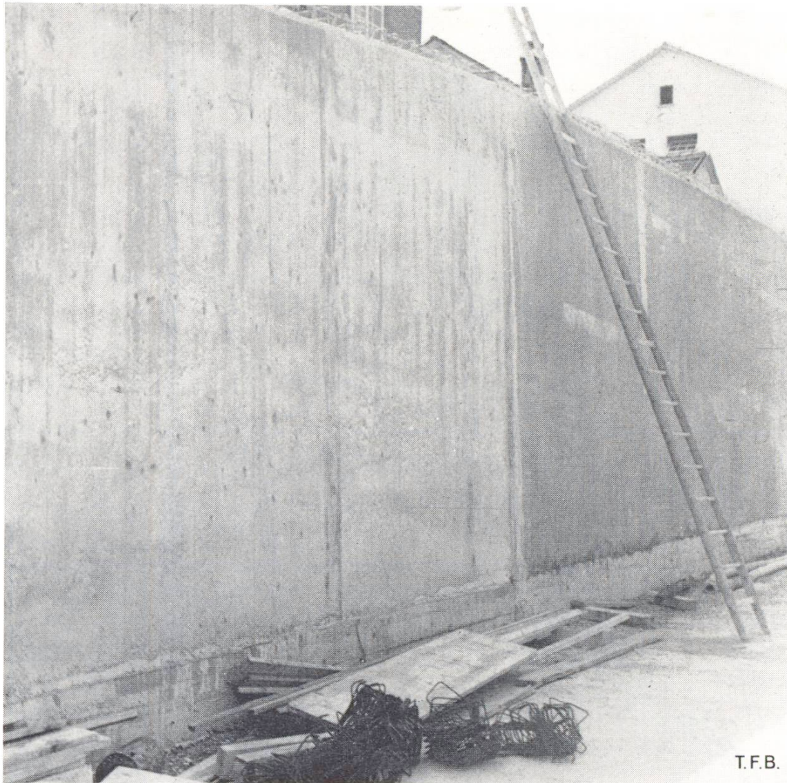
Abb. 2 Unterschiedliche Grautönung des Betons vertikal und horizontal begrenzt infolge kleiner Unregelmässigkeiten des Wasserzementwertes.
