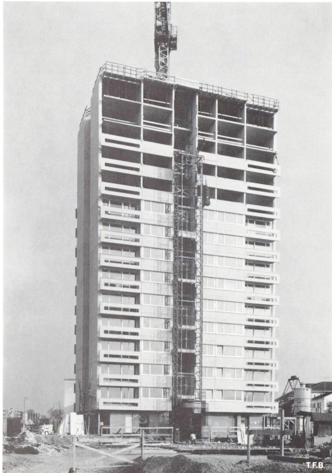
Abb. 3 Wohn-Hochhaus in Zürich, erstellt 1963 in der Allbeton-Bauweise durch die Firma H. Hatt-Haller. Die Fassadenplatten und Balkonbrüstungen sind vorfabriziert.
