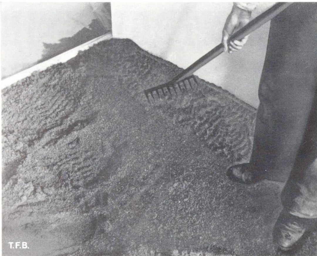
Abb. 1 Der Überzugsmörtel wird mit dem Rechen verteilt.
