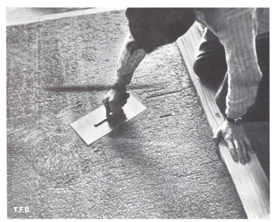
Abb. 4 Abglätten des Überzugs mit der Stahlscheibe.
