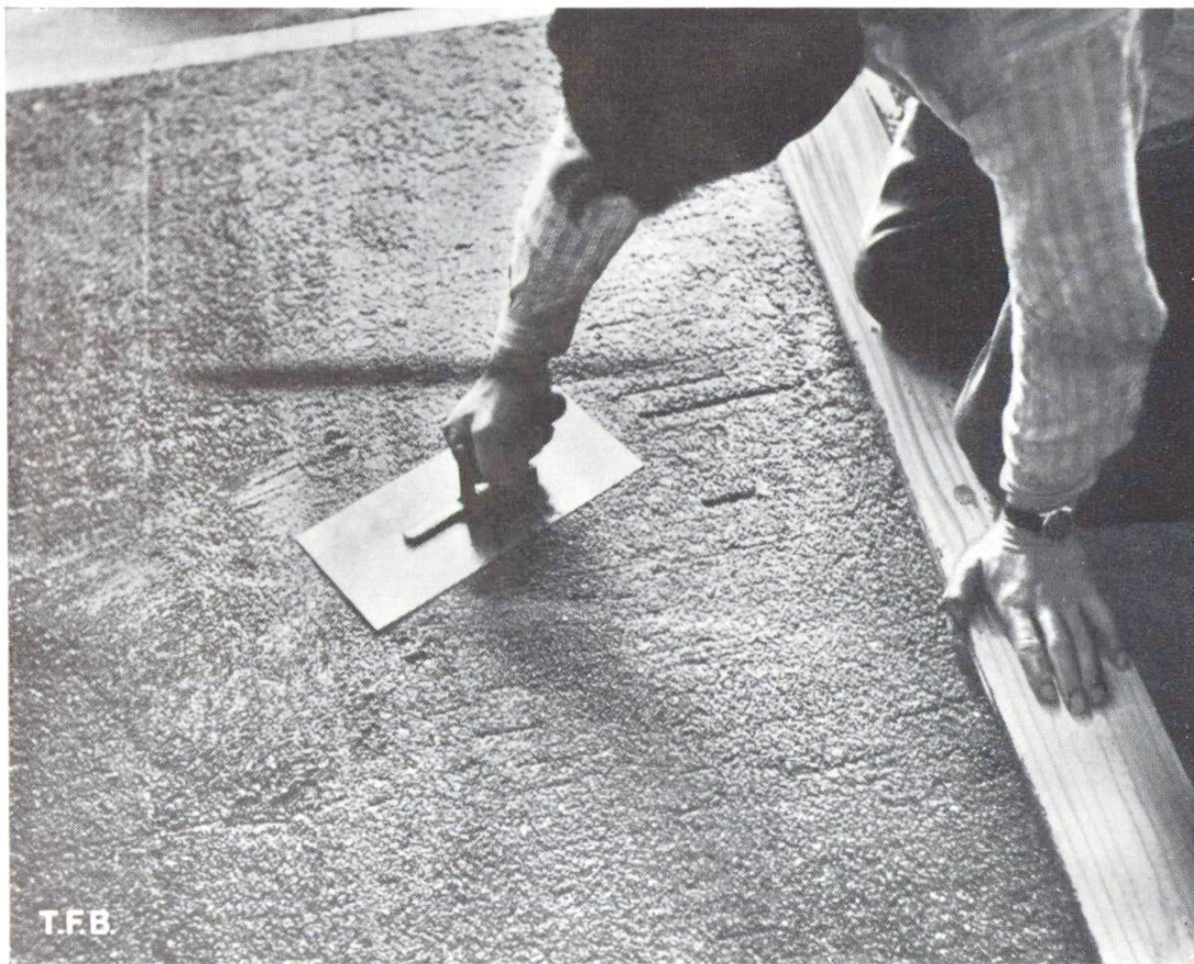
Abb. 4 Abglätten des Überzugs mit der Stahlscheibe.
