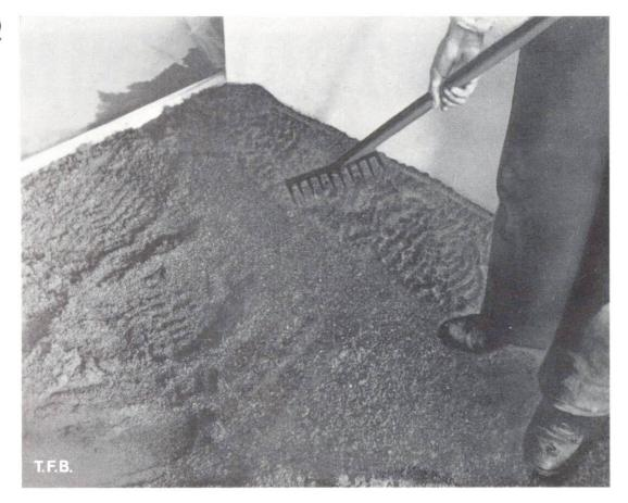
Abb. 1 Der Überzugsmörtel wird mit dem Rechen verteilt.
