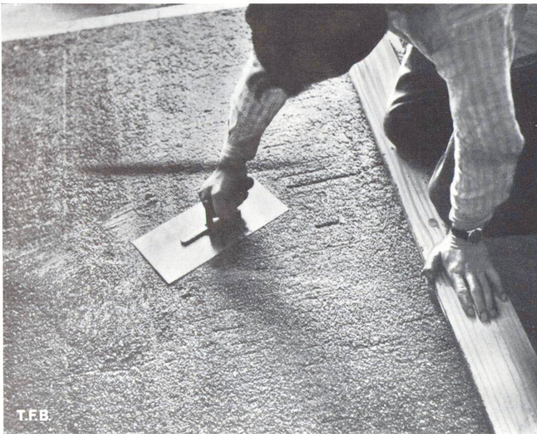
Abb. 4 Abglätten des Überzugs mit der Stahlscheibe.
