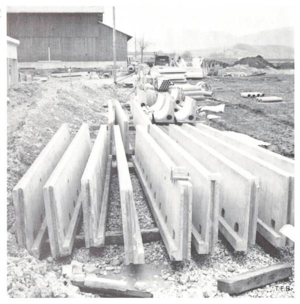
Abb. 1 Verschiedene Bauelemente warten auf den Einsatz. Im Vordergrund Platten für die Mistrinne mit Schubstangenentmistung, dahinter vorfabrizierte Krippen.
