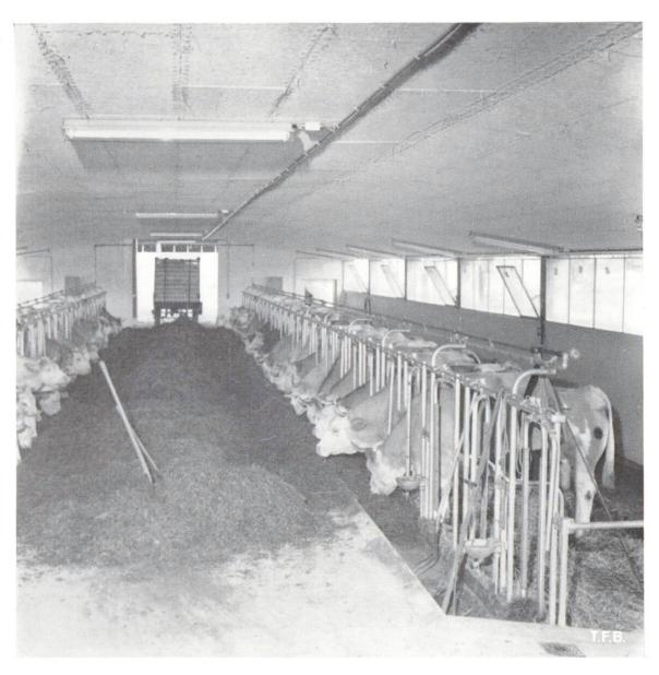
Abb. 7 Der Stall von innen. Einfache, zweckmässige und übersichtliche Anordnung. Bequeme, kostensparende Fütterung. Der Boden ist hier in Ortsbeton ausgeführt. Es können hierfür aber auch vorfabrizierte Platten zum Einsatz kommen, wobei die Lägerplatten z.B. auch aus Lecca-Isolierbeton bestehen.
