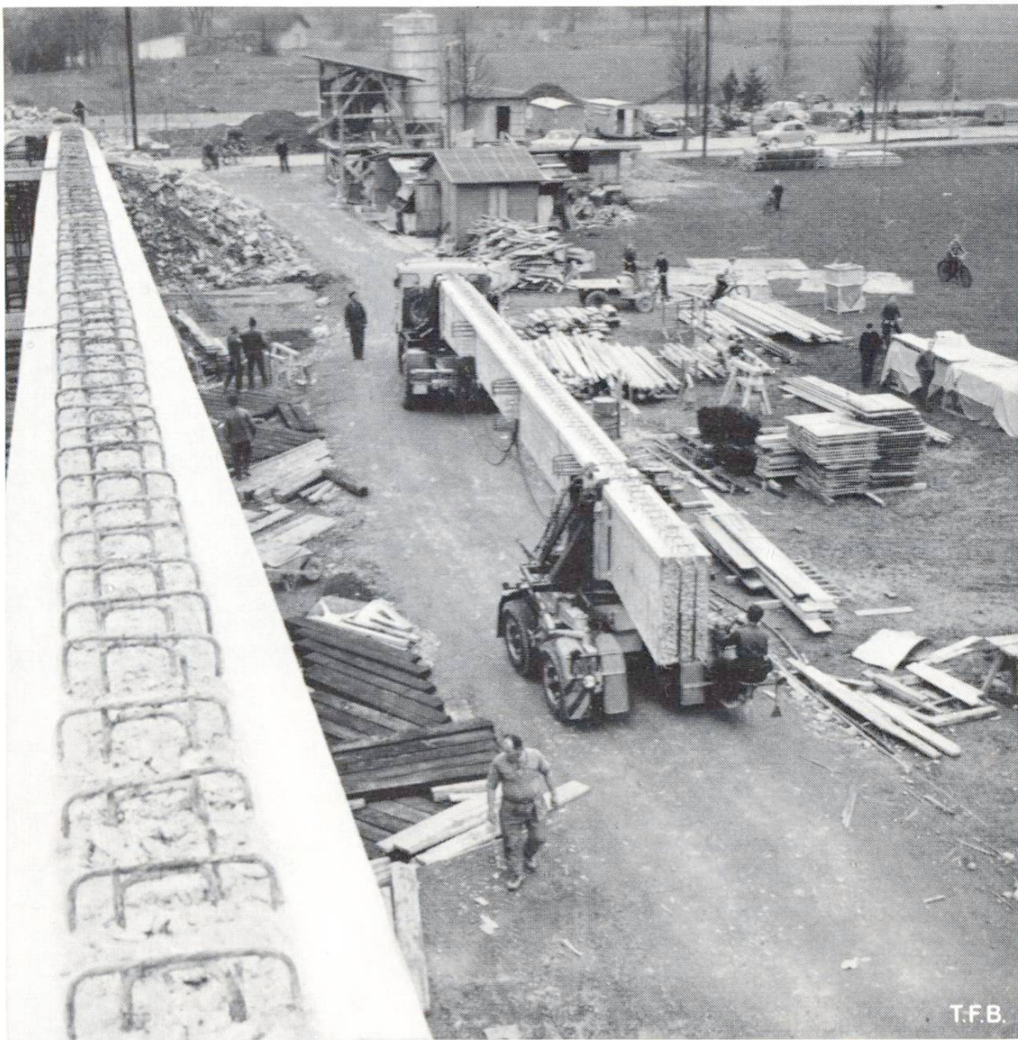
Abb. 3 Zutransport der im Werk vorgefertigten Betonträger
