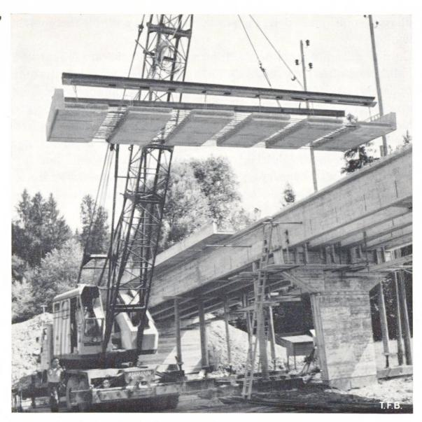
Abb. 6 Montage der Fahrbahnplatten
