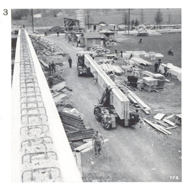
Abb. 3 Zutransport der im Werk vorfabrizierten Betonträger
