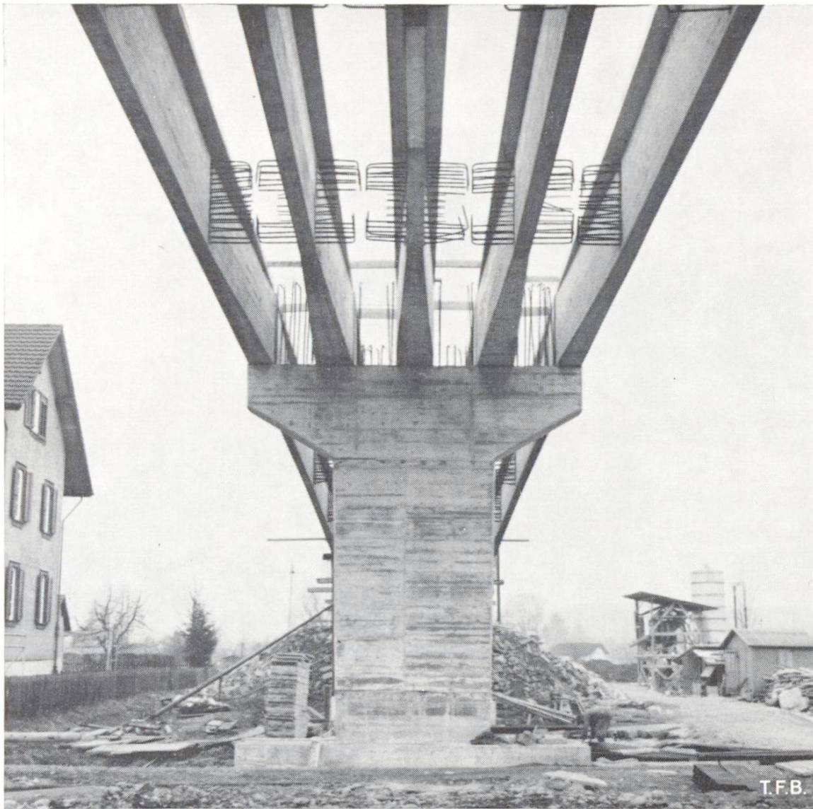
Abb. 5 Montierte Träger
