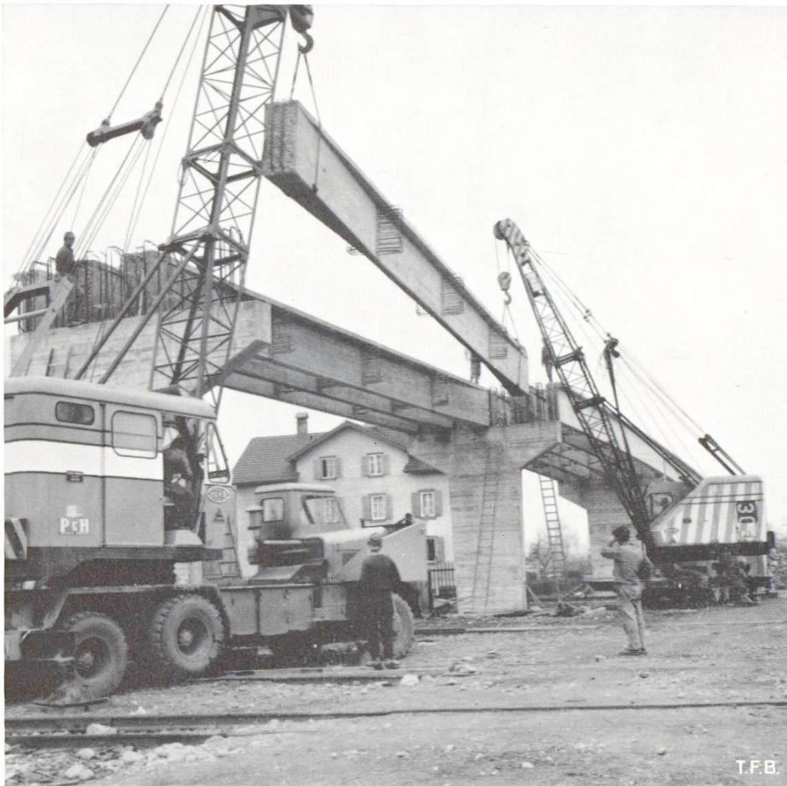
Abb 4. Montage der Träger
