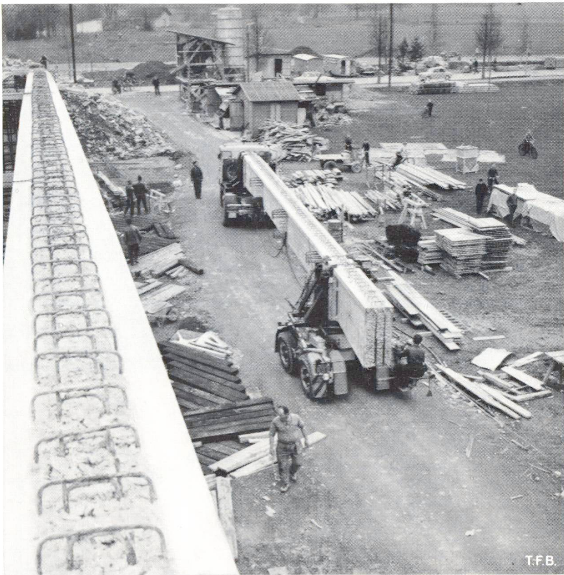
Abb. 3 Zutransport der im Werk vorgefertigten Betonträger
