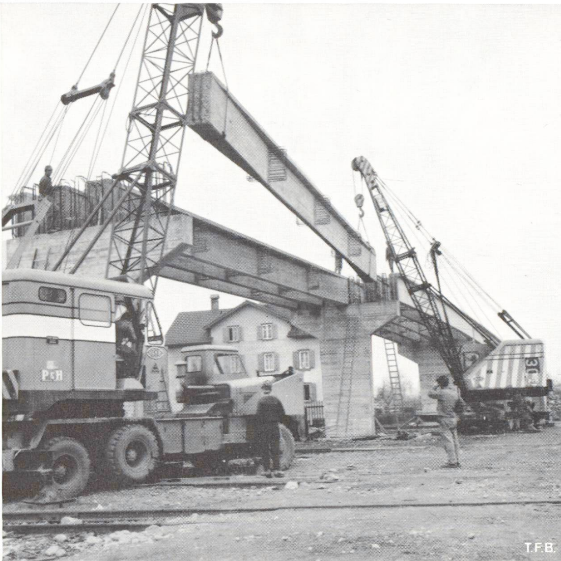
Abb 4. Montage der Träger
