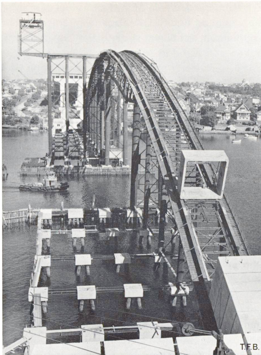
Abb. 3: Das Lehrgerüst mit Durchlass für die Schifffahrt. Eben wird ein Bogenelement zur Montagestelle gefahren.
