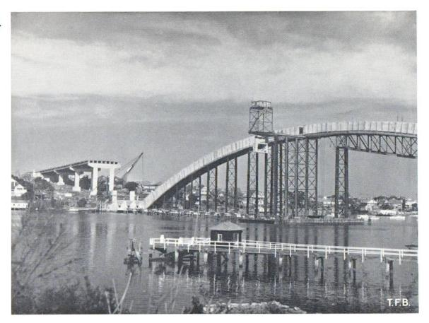
Abb. 4: Das Schlusselement für den ersten Bogen wird hochgezogen. Links erkennt man die mächtigen Joche der Überführung.
