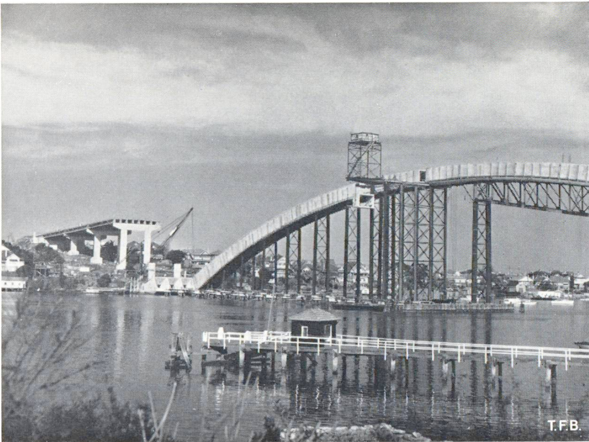
Abb. 4: Das Schlüsselement für den ersten Bogen wird hochgezogen. Links erkennt man die mächtigen Joche der Überführung.
