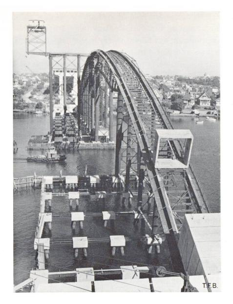
Abb. 3: Das Lehrgerüst mit Durchlass für die Schiffahrt. Eben wird ein Bogenelement zur Montagestelle gefahren.
