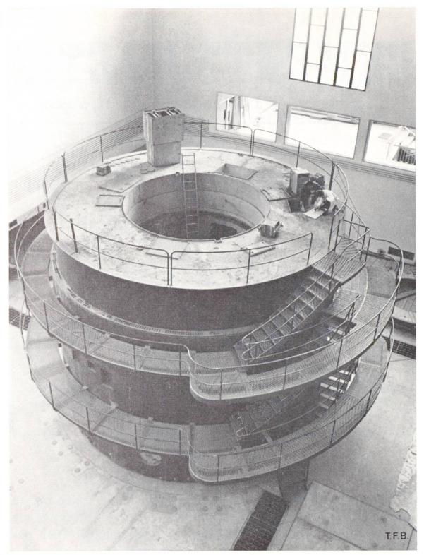
Abb. 1 Reaktorgehäuse im Rohbau fertig erstellt. Das Bild zeigt eindrücklich die wuchtige Masse des Schildes aus schwerem Beton.
