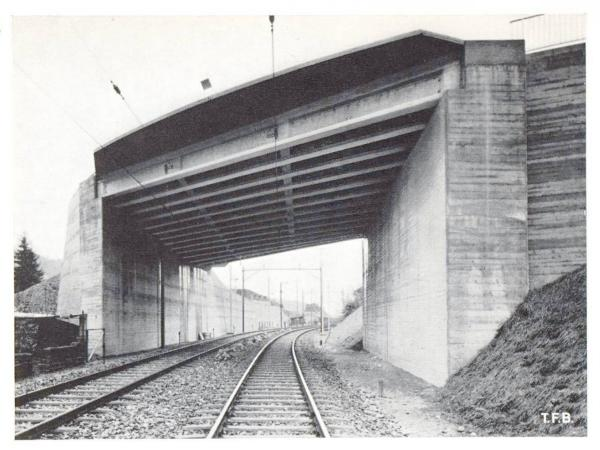
Abb. 3 Strassenüberführung über Eisenbahnlinie mit vorgespannten, vorfabrizierten Betonbalken. Vorfabrikation: Vobag, Adliswil.
