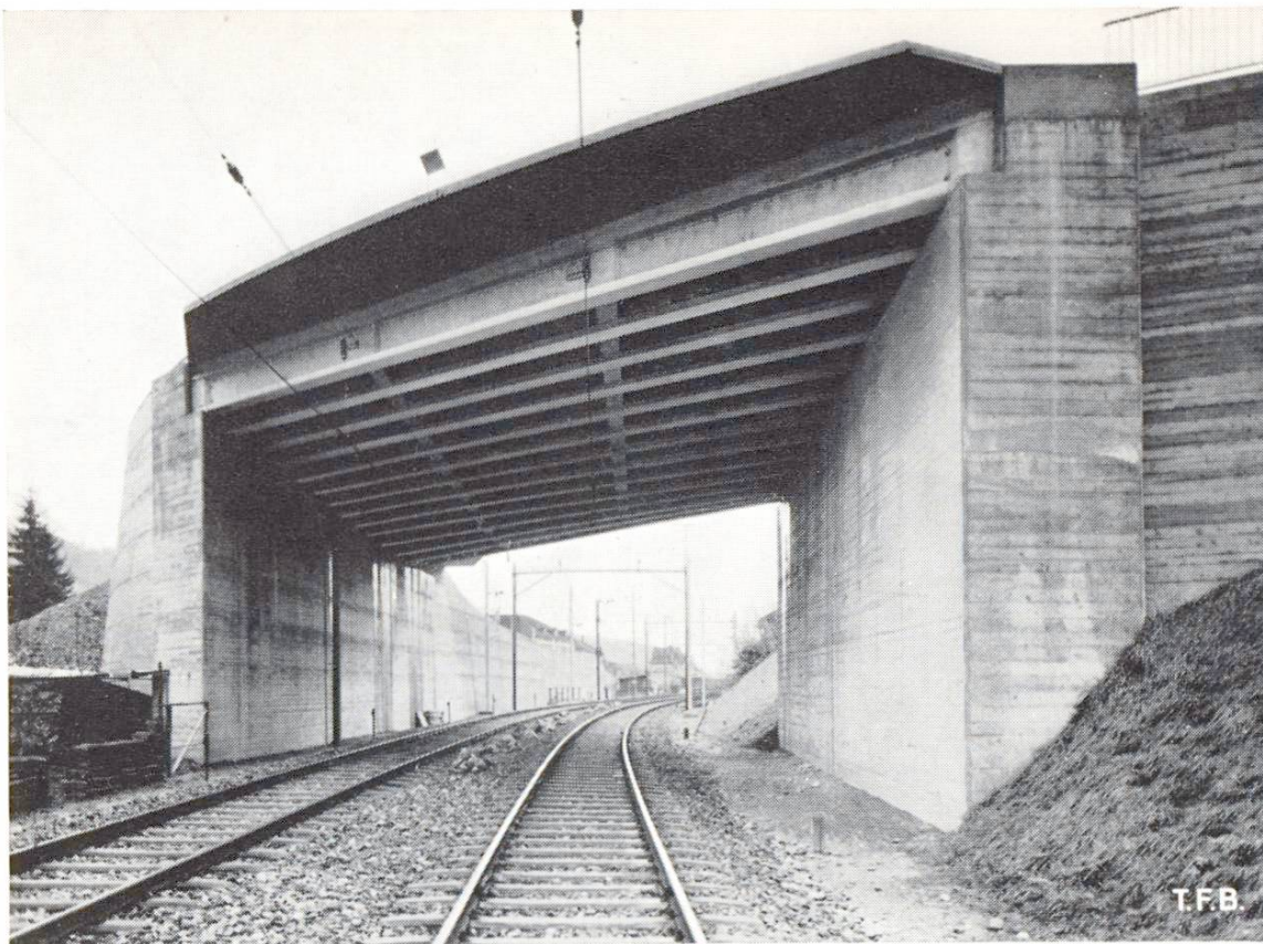
Abb. 3 Strassenüberführung über Eisenbahnlinie mit vorgespannten, vorgefabrizierten Betonbalken. Vorfabrikation: Vobag, Adliswil.
