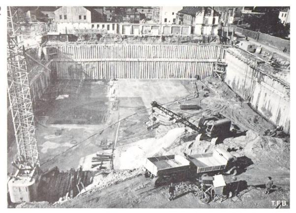
Abb. 1 Baugrubenumschliessung der Baustelle Bayerischer Rundfunk, München, mit einer Benoto-Sekantenwand Typ 880/750.
